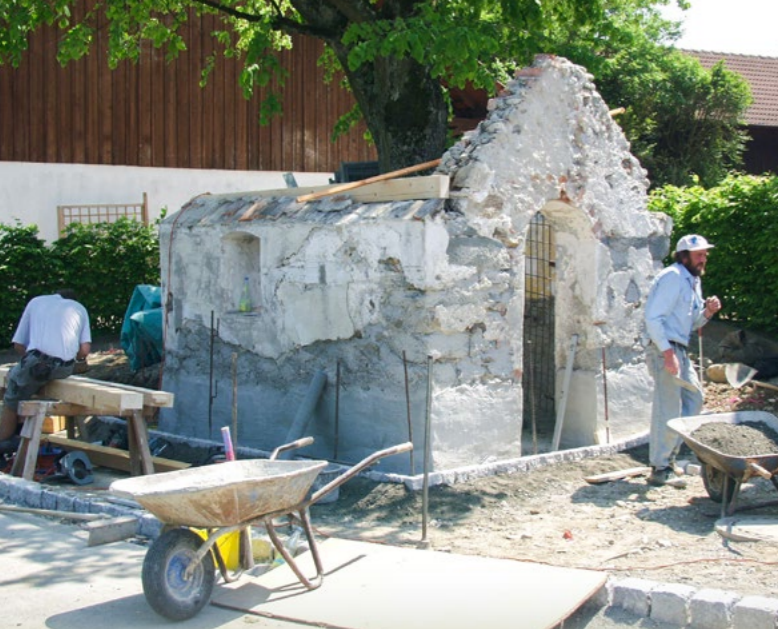
Das Dach war so kaputt, dass es abgebaut werden musste. (Foto: Werner und Maria Berschneider)
