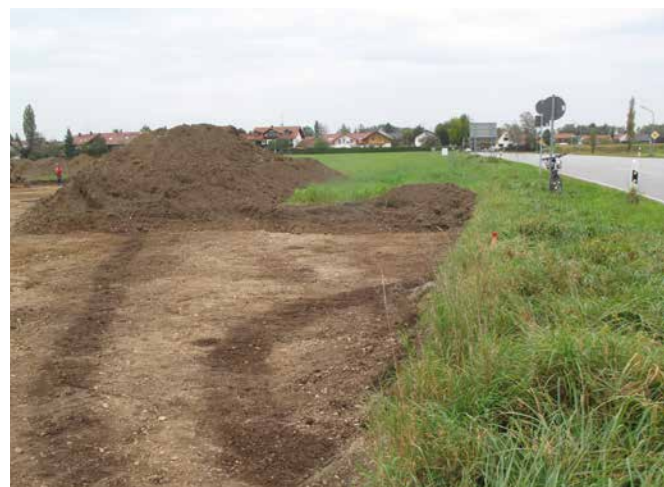
Abtrag des Oberbodens. In der Regel zeichnen sich archäologische Befunde bereits knapp unter der Oberfläche als deutliche Verfärbungen ab.
