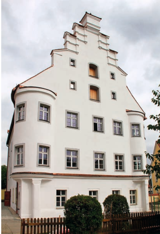
... und nach Abschluss der Instandsetzungsmaßnahmen
