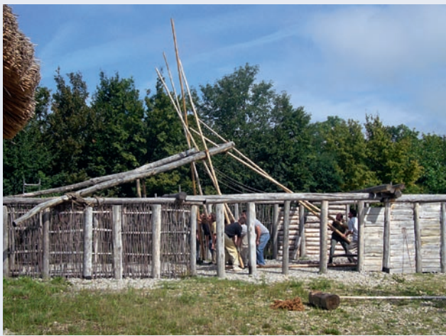
1. Ehrenamtliche Mitarbeiter errichten den Dachstuhl eines bajuwarischen Langhauses (Foto: Bajuwarenhof Kirchheim)
