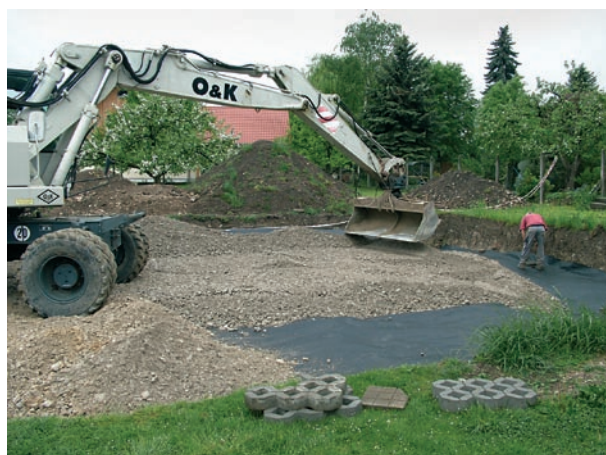
2. Das Schutzvlies wurde anschließend mit Schotter überdeckt und später für das Hausfundament planiert; die Denkmalsubstanz bleibt durch dieses Vorgehen im Boden erhalten (Fotos: BLfD, Bildarchiv)
