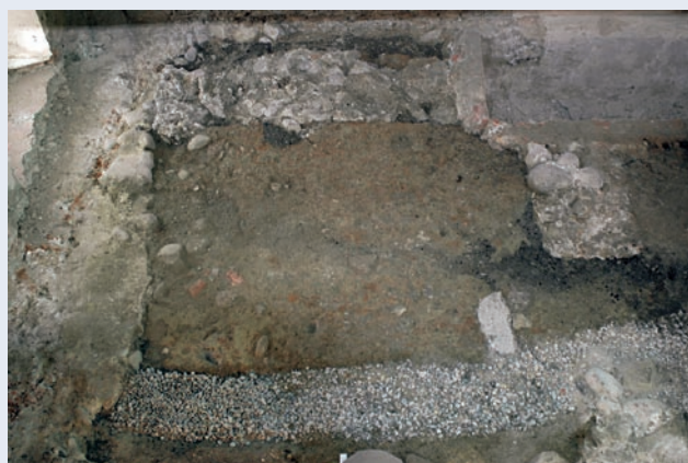
1. Archäologische Untersuchungen im Schloss Murnau im Bereich des Aufzugsschachtes; vom Eingriff nicht betroffene Flächen blieben unberührt und damit erhalten (Foto: Stefan Wolters)
