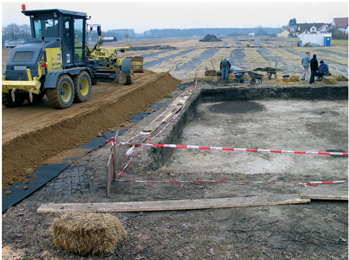
3. Konservatorische Überdeckung eines Bodendenkmals mit Geotextil und Schotterkoffer; im Bereich der Anschlüsse und Kanäle sind Bodeneingriffe notwendig, die nach wie vor bauvorgreifend archäologisch untersucht werden müssen (Foto: BLfD, Bildarchiv)
