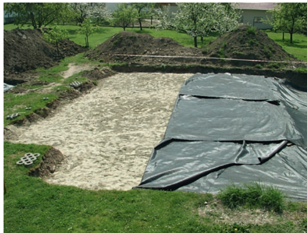
1. Schutzkonzept „konservatorische Überdeckung“: Beim Bau eines Einfamilienhauses im römischen vicus von Kösching, Lkr. Eichstätt, verzichteten die Bauherren auf eine Unterkellerung des Wohnhauses; nach Abtragung der modernen Erdschichten wurde die Baufläche mit einem Geotextil (Vlies) abgedeckt
