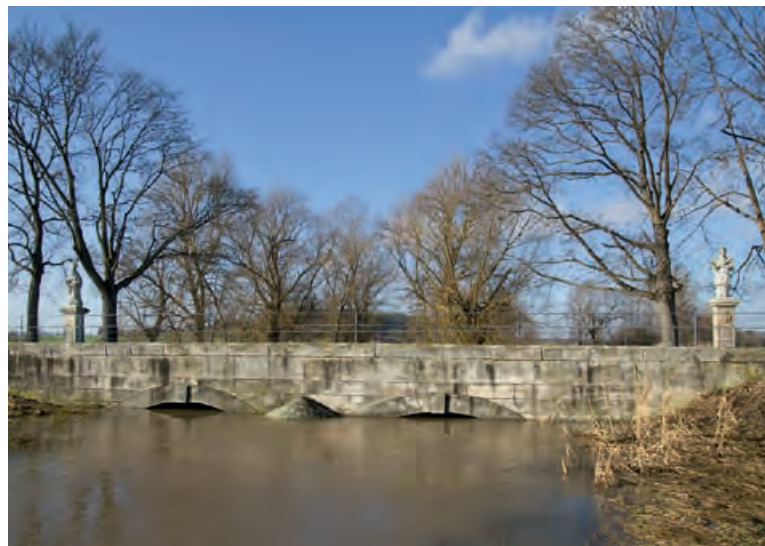
3. Grasmannsdorf, Markt Burgebrach, Lkr. Bamberg; Clesbrücke, Teilansicht (Foto: BLfD, Eberhard Lantz, 2011)
