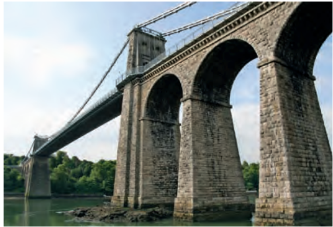
4. Bangor, Wales; Menai-Brücke von Thomas Telford, gilt als erste moderne Hängebrücke der Welt, 1826 (Foto: Gerhard Ongyerth, 2008)
