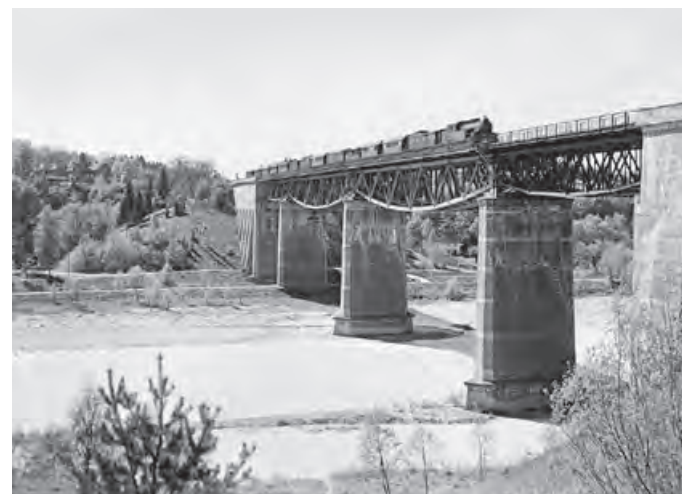
Großhesselohe, Gde. Pullach i. Isartal, Lkr. München; Eisenbahnbrücke über die Isar, 1857 erbaut, 1908 mit Halbparabelträgern umgestaltet, 1983 ersetzt (Foto: BLfD AM2009-1-30-01019650, Gelatinetrockenplatte, um 1925)
