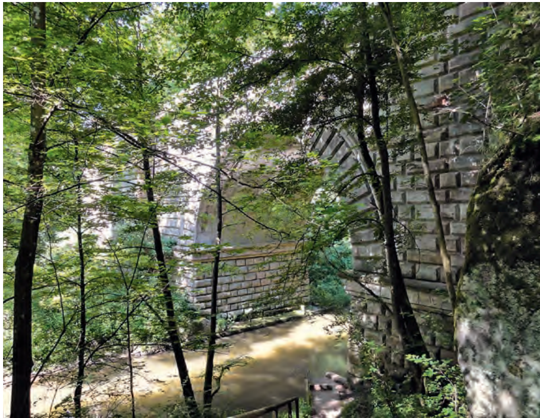
Brückkanal, Bogenstellung (Foto: Michael Volk, 2011)
