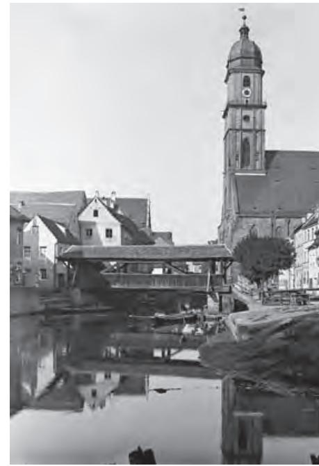
Amberg; sog. Schiffbrücke über die Vils, hölzerner Ständerbau auf gemauerten Pfeilern mit Walmdach, 1761 (Foto: BLfD AM2009-12-7-01023374, Gelatinetrockenplatte, Friedrich Karl Weysser, um 1908)
