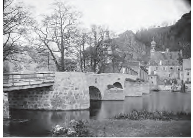
7. Kallmünz, Lkr. Regensburg; Naabbrücke (Foto: BLfD, um 1910)
