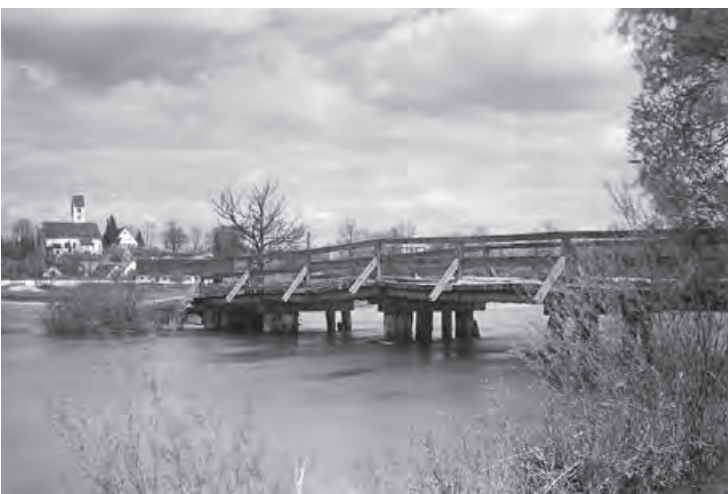
Mitterndorf, Stadt Dachau; ehem. Holzbrücke über die Amper mit Blick auf die Pfarrkirche St. Nikolaus (Foto: BLfD AM2009-1-30-01019629, Gelatinetrockenplatte, um 1925)
