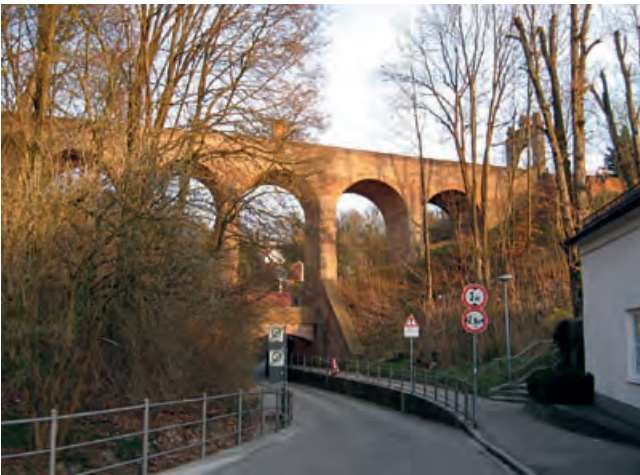
Dingolfing, Lkr. Dingolfing-Landau; Hochbrücke (Foto: Michael Schmidt)
