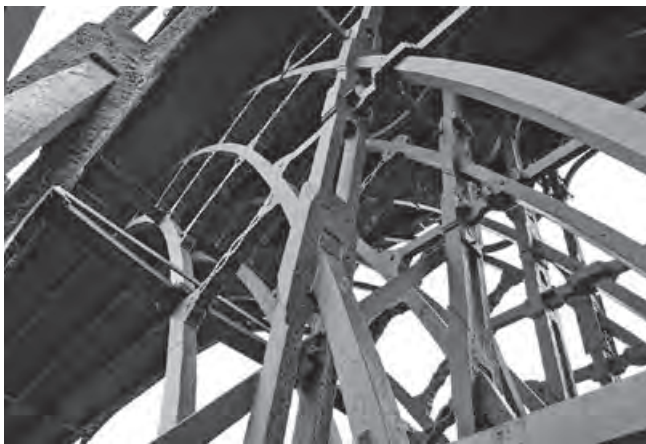
3. Ironbridge bei Coalbrookdale, England; erste Gusseisenbrücke der Welt, 1779 (Foto: Gerhard Ongyerth, 2008)
