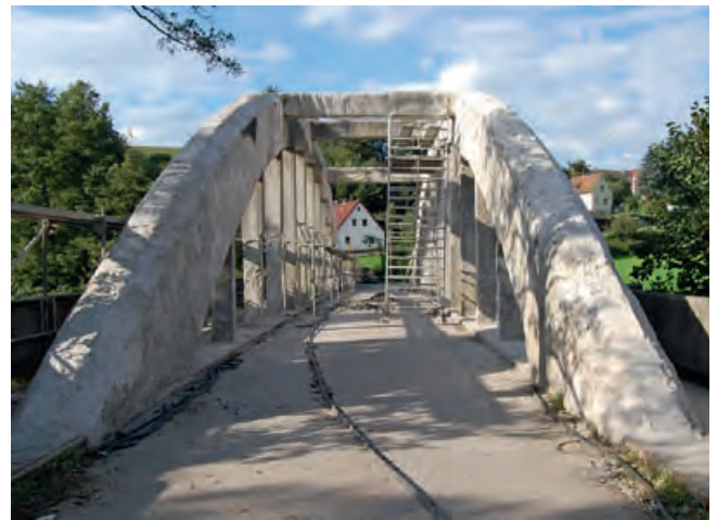
Pfreimd-Brücke während einer Zustandsuntersuchung (Foto: Leo Berberich, 25.08.2010)
