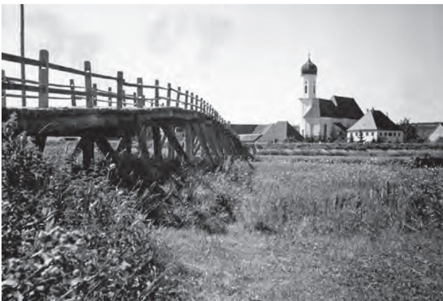
3. Donaumünster, Lkr. Donau-Ries; Holzbrücke (Foto: BLfD, um 1930)
