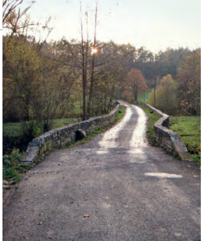
Oberer Brücke von Nordwesten (Foto: Ingenieurbüro Federlein, Mellrichstadt)
