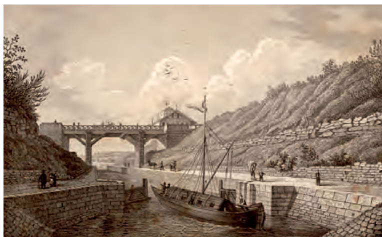
7. „Dörlbacher Einschnitt“ mit Brücke des Ludwig-Kanals, Stahlstich von Alexander Marx, 1845 (nach: Pittoreske Ansichten des Ludwig-Donau-Main-Kanals , hrsg. u. gest. v. A. Marx, Nürnberg 1845; Scan: www.hansguener.de/kanal.htm )
