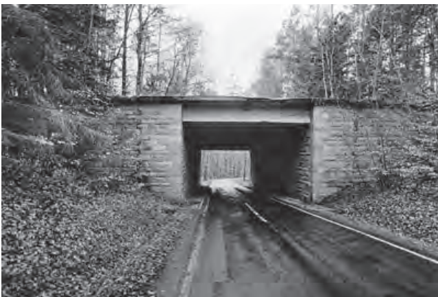
Bauwerk 91, Unterführung der Kreisstraße Burgsinn–Gräfendorf (Foto: BLfD, Eberhard Lantz)
