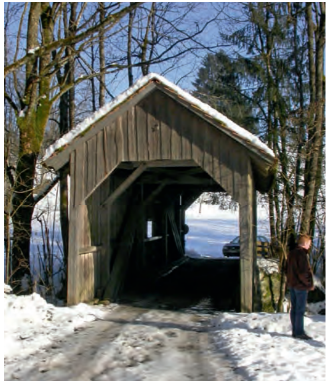
Immen, Gde. Sigmarszell, Lkr. Lindau; Brücke über die Leiblach, 1876, vor der Sanierung (Foto: BLfD, Hildegard Sahler, 2003)
