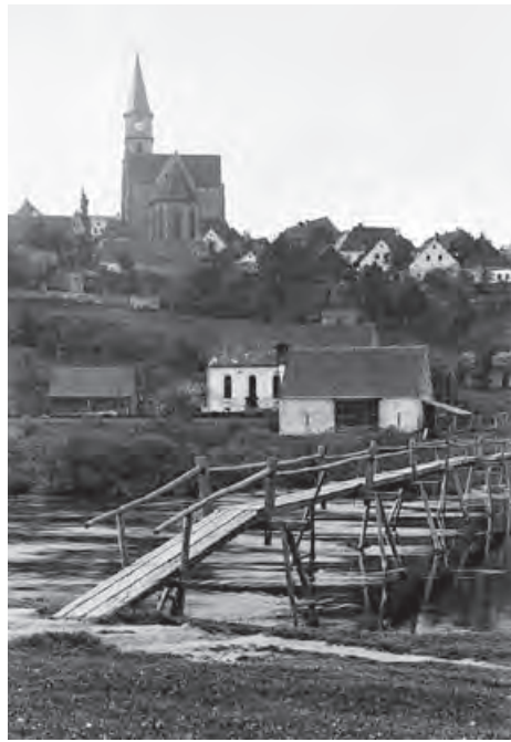
Nabburg, Lkr. Schwandorf; ehem. Holzsteg über die Naab, Konstruktion aus Steckverbindungen (Foto: BLfD 01024386, Gelatinetrockenplatte, um 1909)
