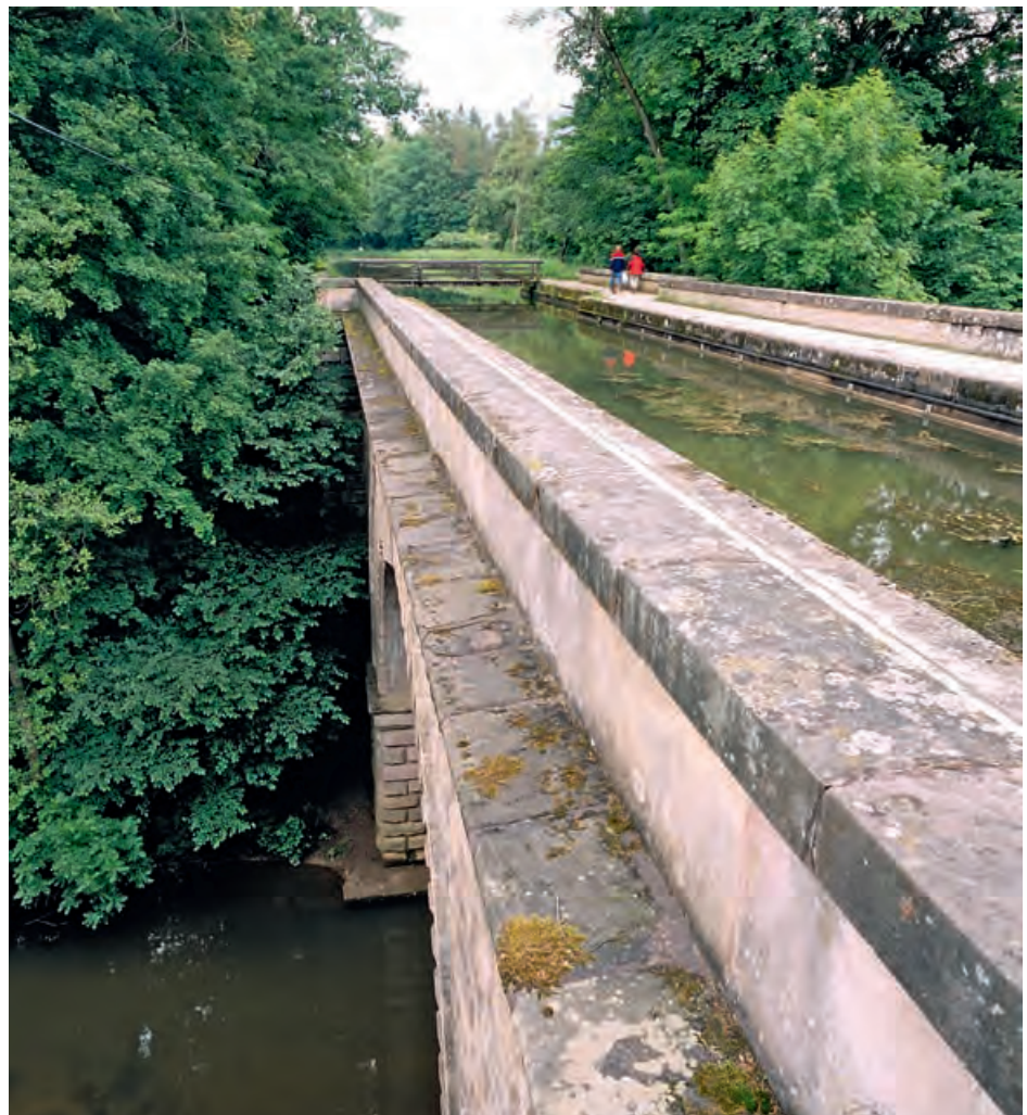
Schwarzenbruck, Lkr. Nürnberger Land; Brückkanal des Donau-Main-Kanals, auf der Brücke (Foto: BLfD, Eberhard Lantz, 2002)
