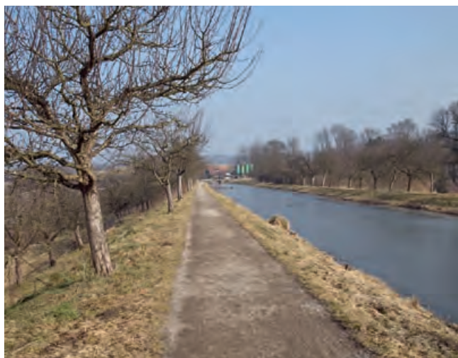
5. Burgthann, Lkr. Nürnberger Land; Distellochdamm des Ludwig-Kanals, 1849 (Foto: BLfD, Eberhard Lantz, 2011)
