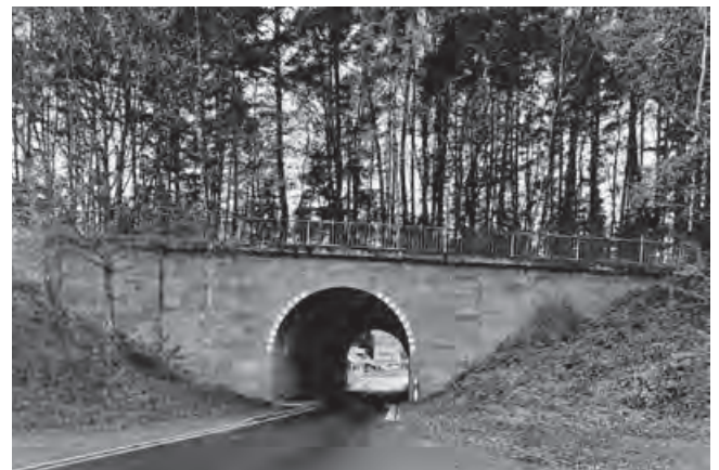
Bauwerk 25, Unterführung der Straße Rupboden–Weißbach (Foto: BLfD, Eberhard Lantz)
