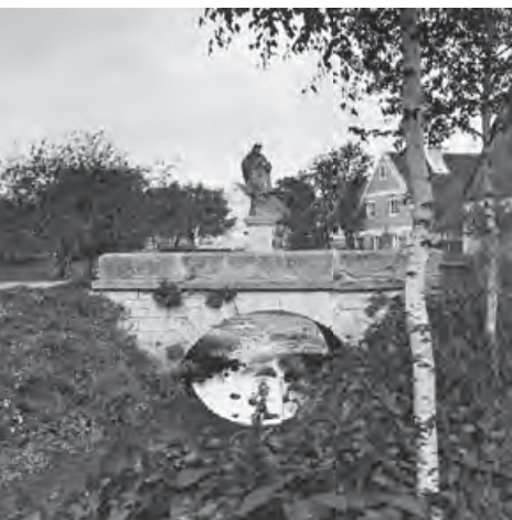
Oben: Maihingen, Lkr. Donau-Ries; Steinbrücke über die Mauch, Mitte 18. Jh. mit hl. Johann Nepomuk von 1728 (Foto: BLfD, Gelatinetrockenplatte, um 1934/35)
