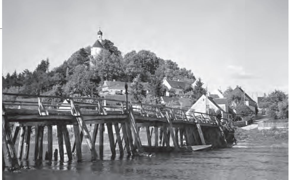
Rechts: Wörnitzstein, Stadt Donauwörth, Lkr. Donau-Ries; Holzbrücke über die Wörnitz, um 1900 errichtet, im Frühjahr 1945 abgebrochen (Foto: BLfD, Gelatinetrockenplatte, um 1937)
