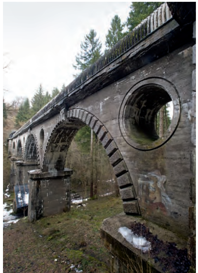
Teufelsgraben-Aquädukt, Schrägsicht, das unbewehrte Betongewölbe am Scheitel mit einer Dicke von 0,75 m, sichtbare Schichtgrenzen und Schalungsabdrücke (Foto: BLfD, Michael Forstner 11004296, 2011)
