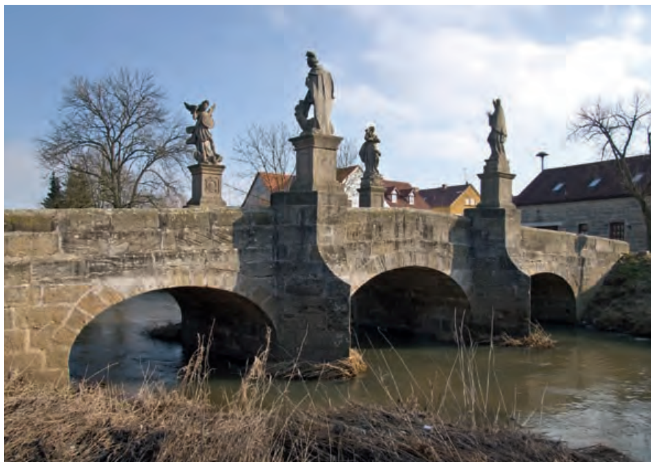
7. Frickendorf; Brücke über die Baunach, Gesamtansicht – vgl. historische Aufnahme S. 50 (Foto: BLfD, Eberhard Lantz, 2011)
