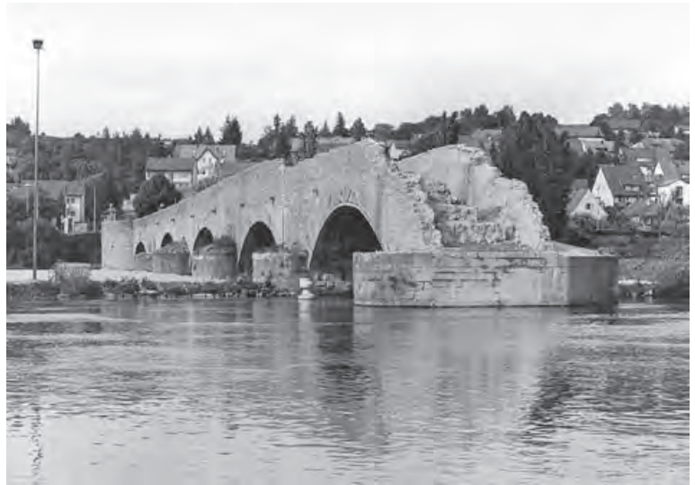
Westlicher Teil der Brücke, nach Abbruch des Mittelteils (Foto: BLfD, Eberhard Lantz 20070504-36, 2007)
