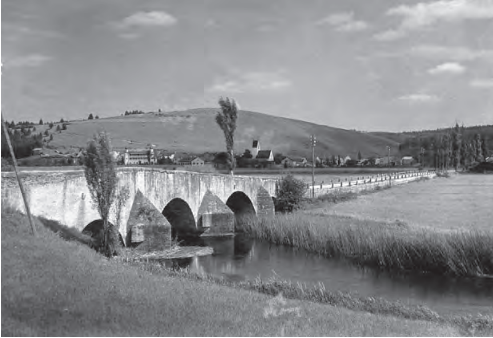
Pfünz, Gde. Walting, Lkr. Eichstätt; vierbogige Steinbrücke über die Altmühl, im 19. Jh. erneuert, heute für den Straßenverkehr gesperrt (Foto: BLfD AM2008-4-21-01013914, Gelatinetrockenplatte, um 1927)
