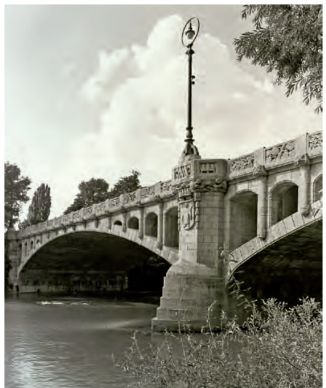
15. München; Maximiliansbrücke (Foto: BLfD, Joachim Sowieja, 2001)
