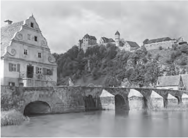
6. Harburg, Lkr. Donau-Ries; Wörnitzbrücke (Foto: BLfD 01046013, Gelatinetrockenplatte, um 1937)
