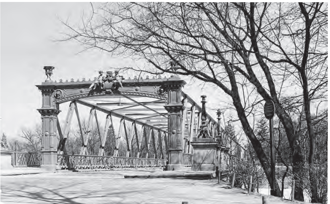
München; Wittelsbacherbrücke über die Isar, 1875 als stählerne Fachwerkkonstruktion errichtet, 1904 durch Betonbrücke mit Muschelkalkverkleidung ersetzt (Foto: BLfD AM2009-1-30-01019470, Gelatinetrockenplatte, um 1890)
