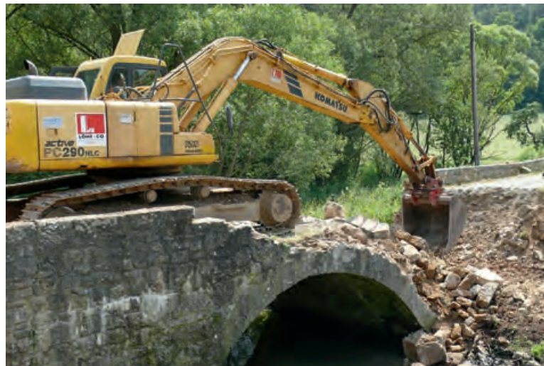
Abbruch der Oberen Brücke im Jahr 2010 (Foto: BLfD, Agnes Rahm)
