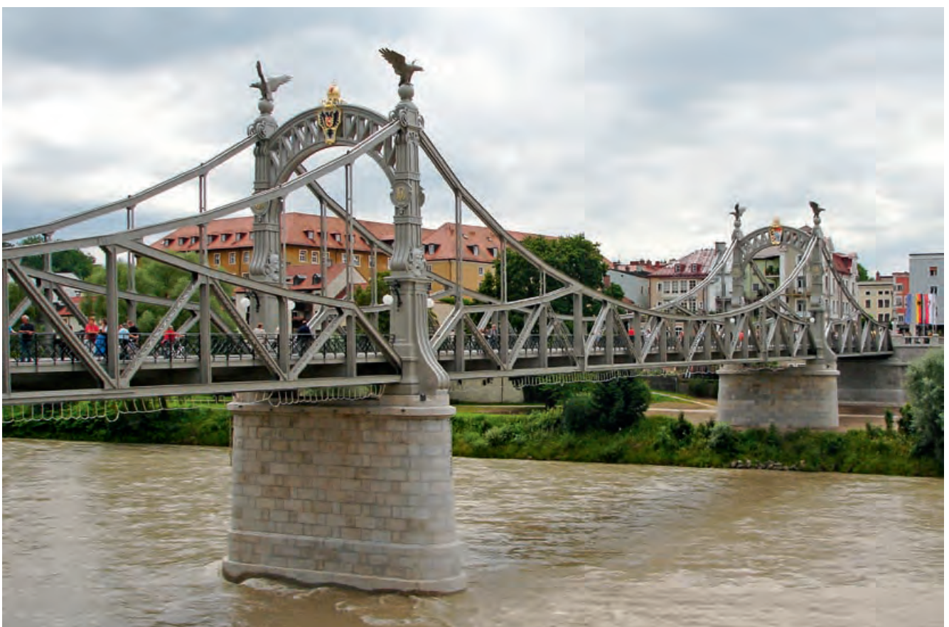
Salzachbrücke nach der Restaurierung mit rekonstruierter Farbigekeit der Bauzeit von 1903 (Foto: BLfD, Martin Mach, 2007)
