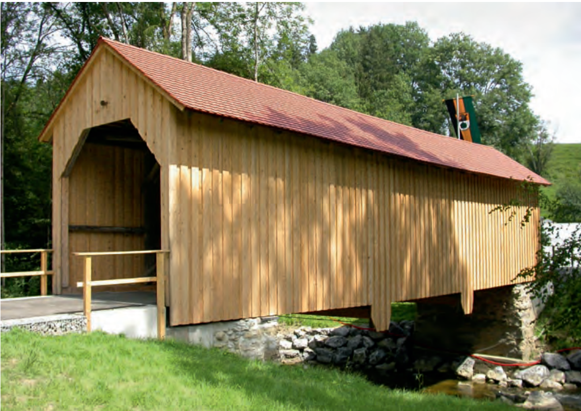
Immen; sanierte Brücke am Tag der Einweihung, 29. Juli 2007 (Foto: BLfD, Hildegard Sahler)
