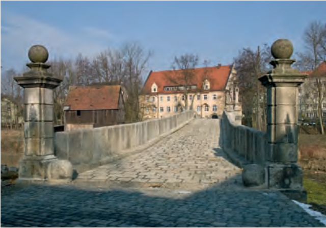
Fischhofbrücke, Blick auf den neu verlegten Originalbelag aus Granitkrustenplatten (Foto: BLfD, Eberhard Lantz 0611103004, 2011)
