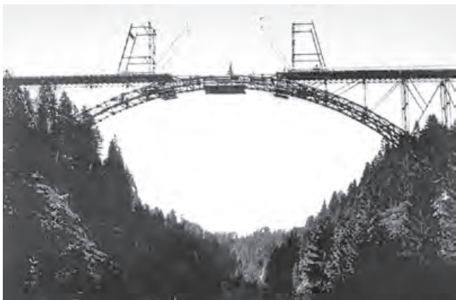
12. Echelsbach, Lkr. Weilheim-Schongau; Ammerbrücke während der Bauarbeiten, um 1929 – vgl. Abb. S. 44 (Foto: StBA Weilheim)
