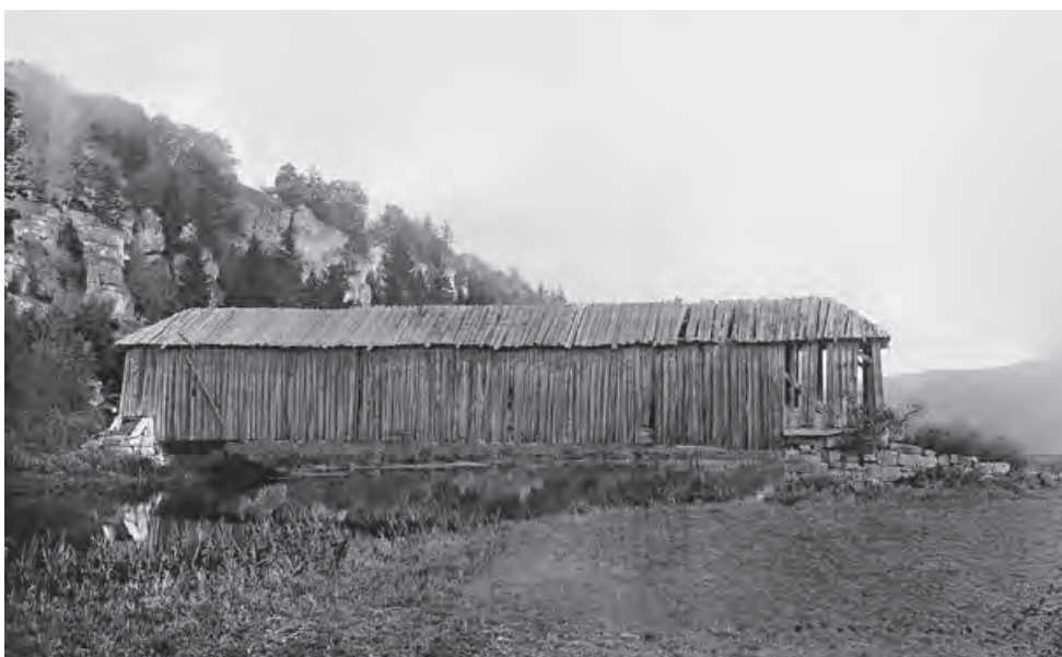
Unten: Brunnmühle, Gde. Walting, Lkr. Eichstätt; hölzerne Brücke über die Altmühl in Fachwerk- konstruktion von 1789, 1926 abgebrochen (Foto: BLfD AM2008-4-21-01013687, Gelatinetrockenplatte, um 1905)
