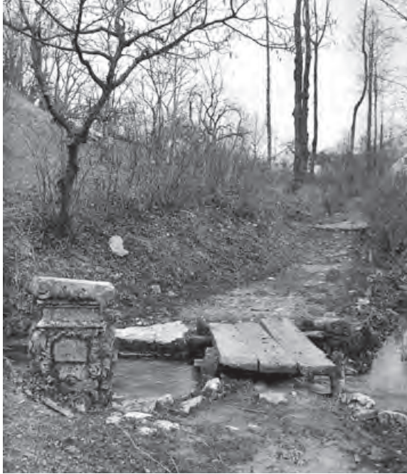
4. Stadtsteinach, Lkr. Kulmbach; archaische Brückenkonstruktion über den Zaubach, historische Aufnahme (Foto: Durmayer)
