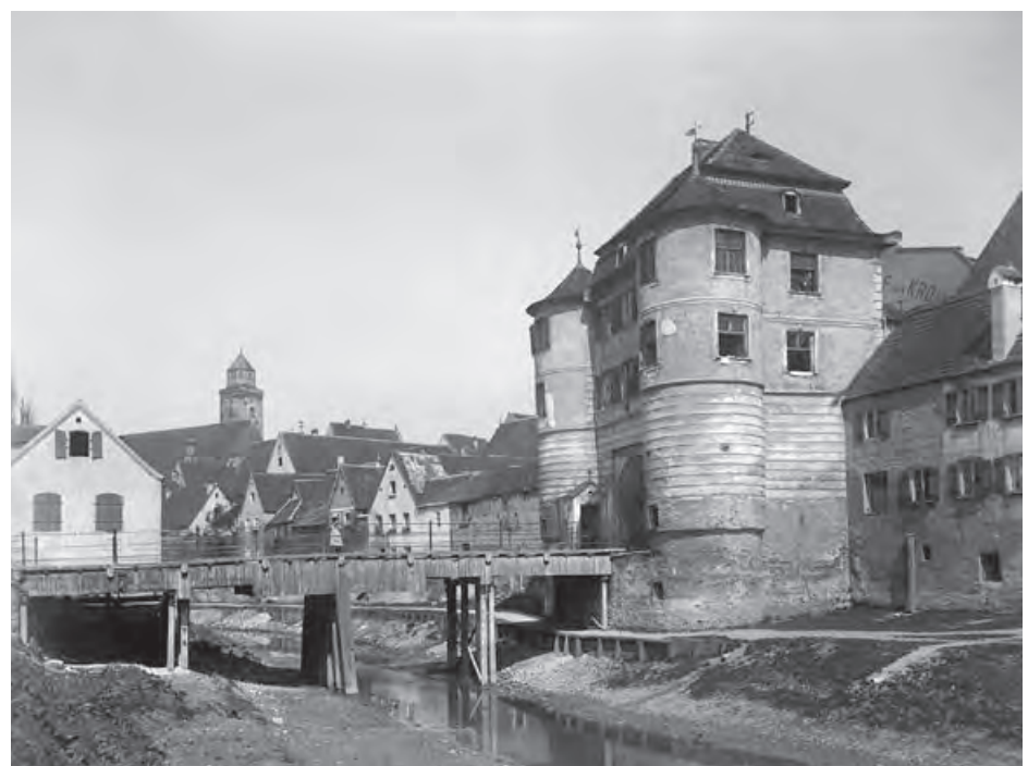
Unten: Donauwörth, Lkr. Donau-Ries; alte Holzbrücke vor dem Rieder Tor; heute durch eine Stein- und Betonkonstruktion ersetzt (Foto: BLfD 01020689, Gelatinetrockenplatte, um 1905)
