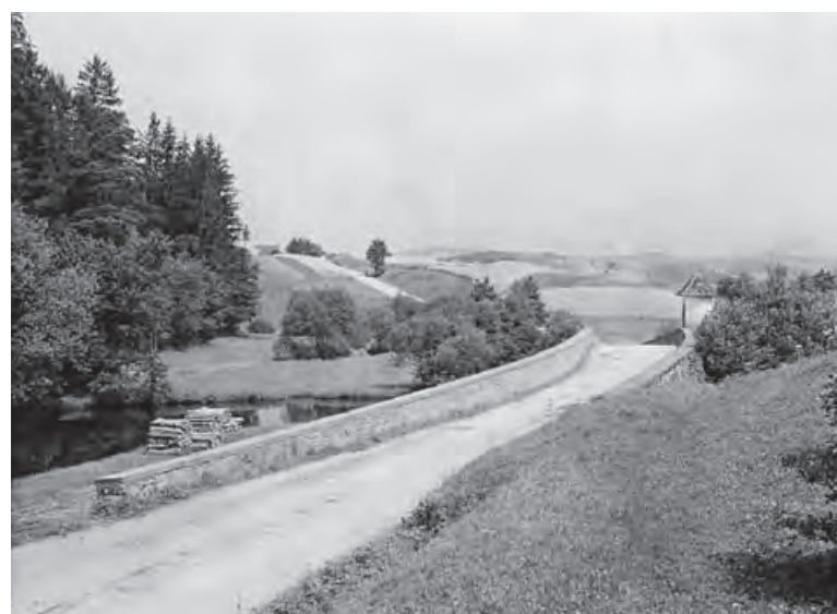
Brückenbahn mit Brüstung (Foto: BLfD AM2009-12-10-01026846, Gelatinetrockenplatte, Joseph Maria Ritz, vor 1931)
