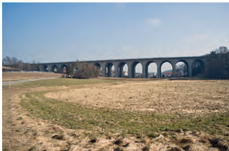
6. Geisenhausen, Gde. Schweitenkirchen, Lkr. Pfaffenhofen a. d. Ilm; Autobahnviadukt Holledau, 1937, mit einer Gesamtlänge von 378 m (Foto: BLfD, Michael Forstner, 2011)
