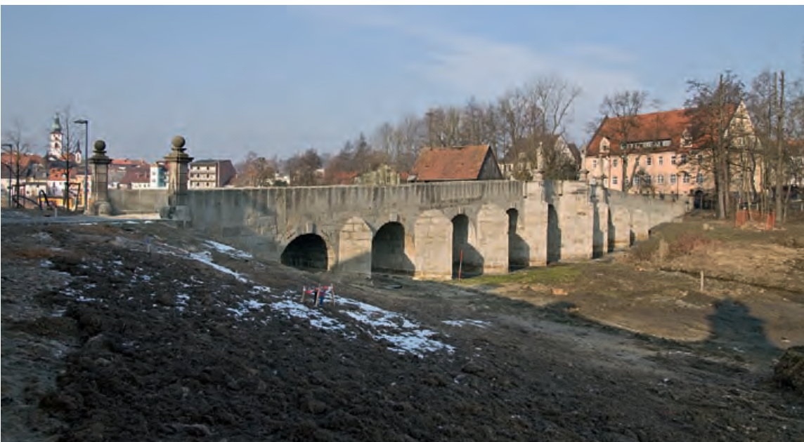
Fischhofbrücke, Gesamtansicht (Foto: BLfD, Eberhard Lantz 0611103006, 2011)
