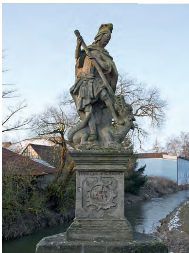
6. Frickendorf, Stadt Ebern, Lkr. Haßberge; Brücke über die Baunach mit hl. Georg, 1774 (Foto: BLfD, Eberhard Lantz, 2011)
