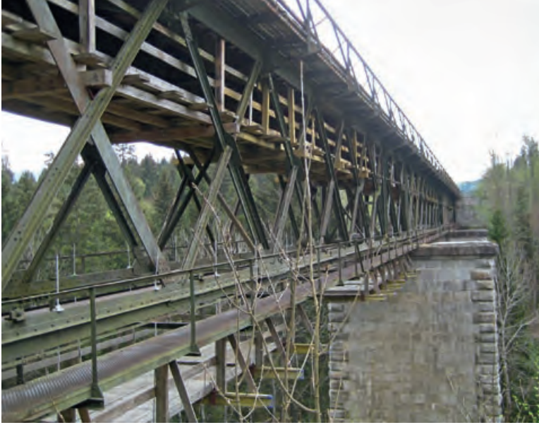
Ludwigsthal, Lkr. Regen; Deffernikbrücke, mit außermittig aufliegendem Brückenträger für den möglichen zweigleisigen Ausbau (Foto: BLfD, Julia Ludwar, 2011)
