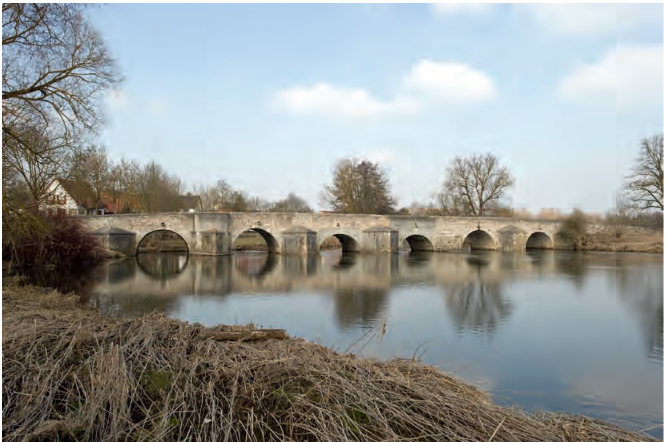
1. Ebermergen, Stadt Harburg (Schwaben), Lkr. Donau-Ries; Würnitzbrücke, wohl 17. Jahrhundert – vgl. historische Aufnahme S. 52 (Foto: BLfD, Michael Forstner, 2011)
