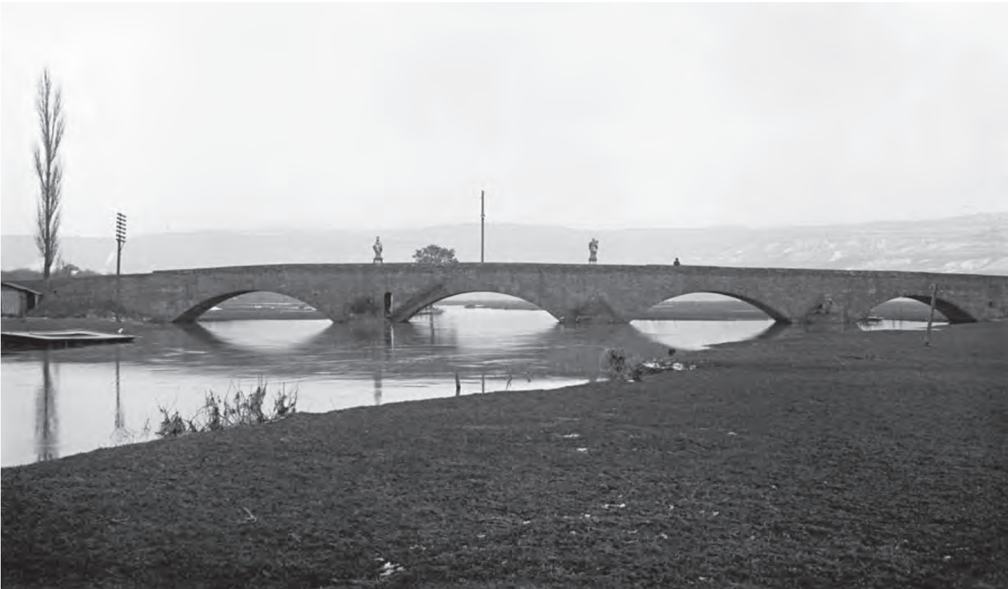
Hammelburg, Lkr. Bad Kissingen; ehem. Steinbrücke über die Saale, im Frühjahr 1945 gesprengt und bis 1952 beseitigt (Foto: BLfD 01032124, Gelatinetrockenplatte, Georg Lösti, vor 1915)
