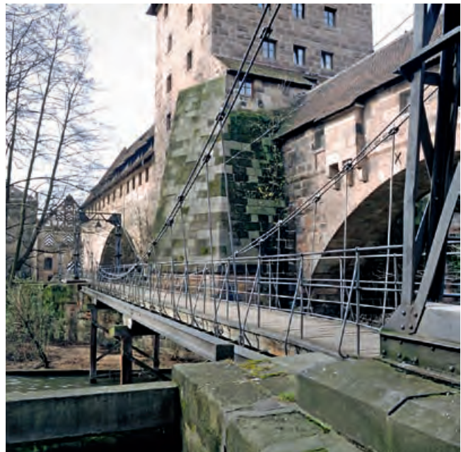
Nürnberg; Kettensteg, vor der Restaurierung (Foto: BLfD, Eberhard Lantz)
