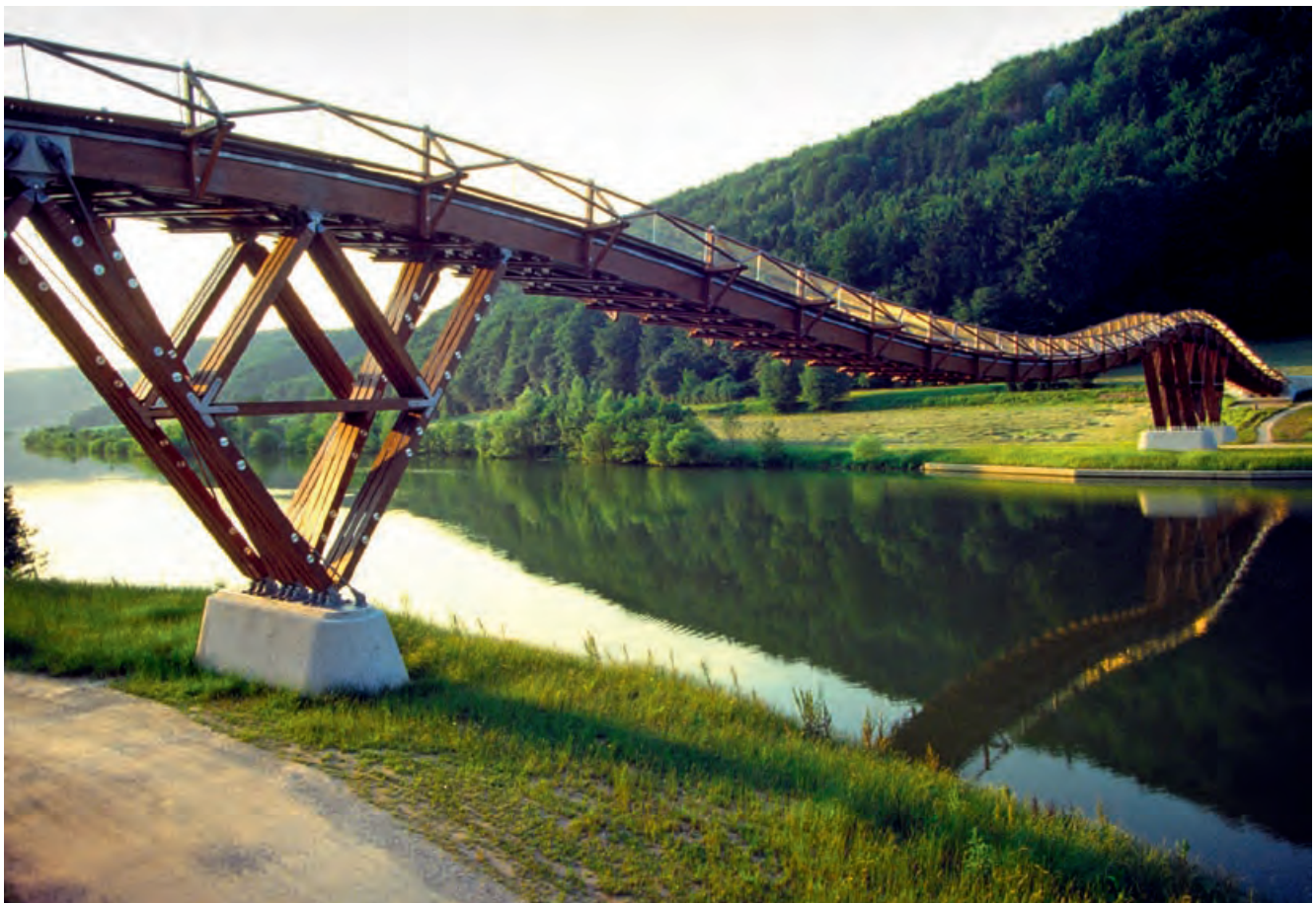
2. Essing, Lkr. Kelheim; Kanalbrücke, 1986 (Foto: Richard J. Dietrich)
