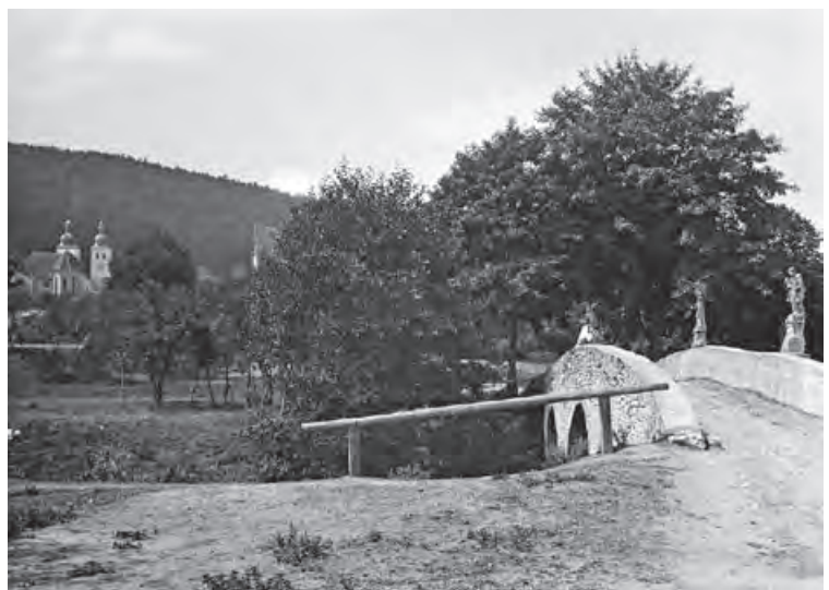
Oberpfalz: Plankstetten, Stadt Berching, Lkr. Neumarkt i. d. OPf.; ehem. steinerne Brücke über die Sulz, 18. Jh. (Foto: BLfD AM2009-12-7-01023891, Gelatinetrockenplatte, Friedrich Karl Weysser, um 1907)
