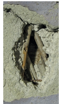
6a, b (Detail). Kehle Ost mit wasserschadensbedingten Putzausbrüchen
