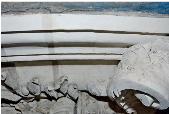
16. Rationelle Applikation des SRF-Films mit der Druckluftpistole mit sehr gutem Reinigungsergebnis auf plastischen Architekturteilen
