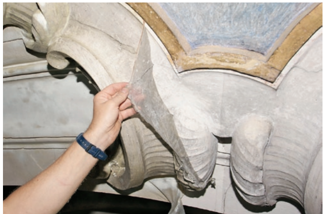
15. Abziehen des Films von plastischem Stuckdekor
