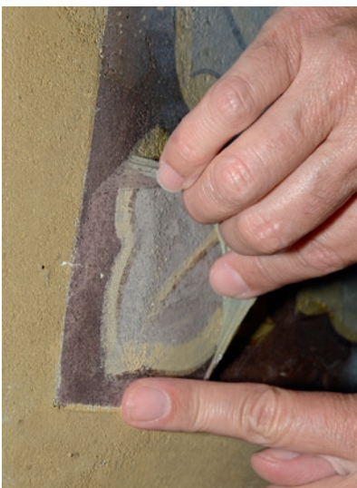
3–5. Ludwigskirche, südl. Querhauswand; links Musterfläche auf der Dekorationsmalerei der 1950er Jahre, Mitte und rechts Abnahme des Latexfilms auf instabiler Malschicht ohne Vorfestigung (Fotos: AG Restauratoren)
