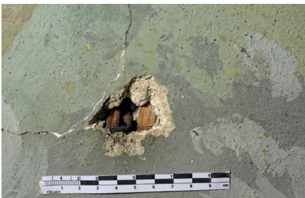
9, 10. Gewölbe Süd, Putzausbrüche über den rostenden Nagelkörpern der Schilfrohrarmierung
