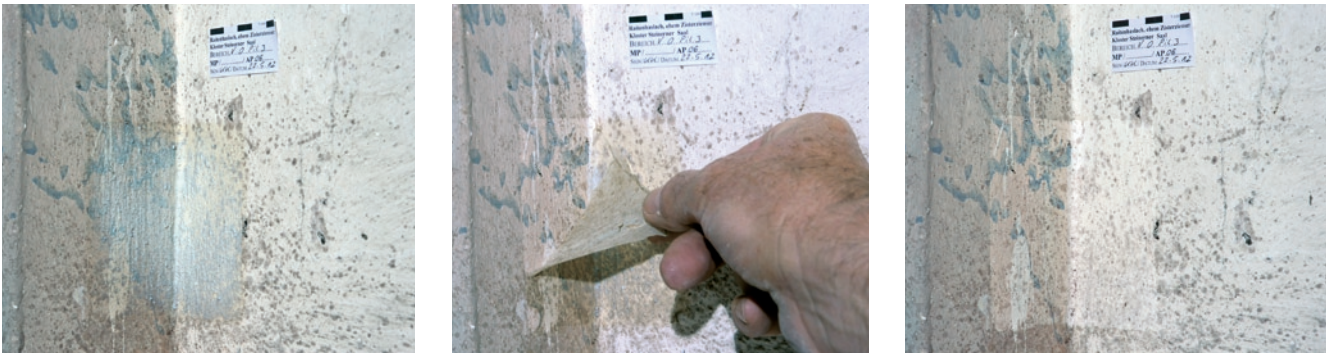
23–25. Arbeitsprobe 6: Die ersten Muster befanden sich im unbemalten aufgehenden Wandbereich, hier über Eck zum marmorierten Pilaster. Der Untergrund ist Ziegelmauerwerk mit Kalkputz und gekalkter Oberfläche. Links der frisch aufgesprühte Latexfilm; in der Mitte Abziehen des Films mit gereinigter Oberfläche; rechts gereinigte Fläche, auch die grauen Rückstände des mikrobiellen Befalls haben sich stark reduziert
