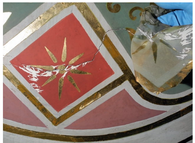
8–11. Ludwigskirche, südl. Seitenkapelle (Marienkapelle); von links nach rechts: 8, 9. Musterfläche im Kuppel-/Wandbereich mit Reduzierung des biogenen Befalls; 10. Abnahme der Verschmutzung; 11. lokale Strappierung der Goldoberfläche (Fotos: AG Restauratoren)
