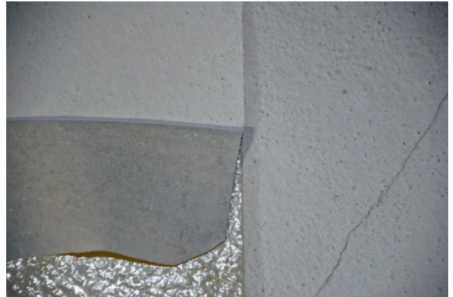
2. Kloster Roggenburg, Kapitelsaal; Reinigung einer stark verschmutzten pulverisierenden Kalkleimfarbenfassung, Einwirkzeit ca. 20 Sek.
