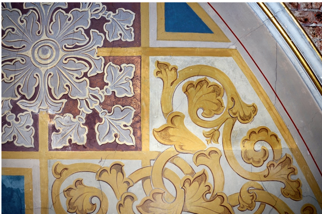
6. Ludwigskirche, südliche Querhauswand; Zustand nach Abnahme des Latexfilms nach ca. 4 Min. Standzeit (Foto: AG Restauratoren)
