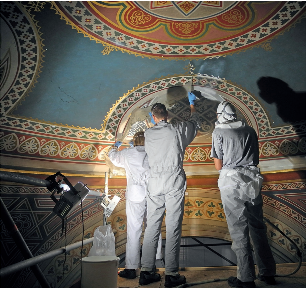
München, Ludwigskirche, südl. Seitenkapelle (Marienkapelle); Musterfläche in der Kuppel, Abnahme des Latexfilms SRF 2 NA nach ca. 4 Minuten Standzeit (Foto: AG Restauratoren)
