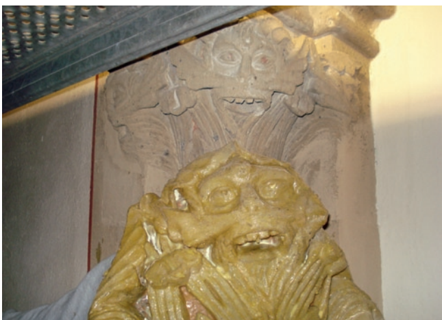
4. Herz-Jesu-Kirche, Säulenkapitell; Selbst komplizierte Oberflächenstrukturen werden mit dem SRF-Film abgebildet – so lassen sich auch Kapillaren reinigen (Fotos: Belfor Europe GmbH)
