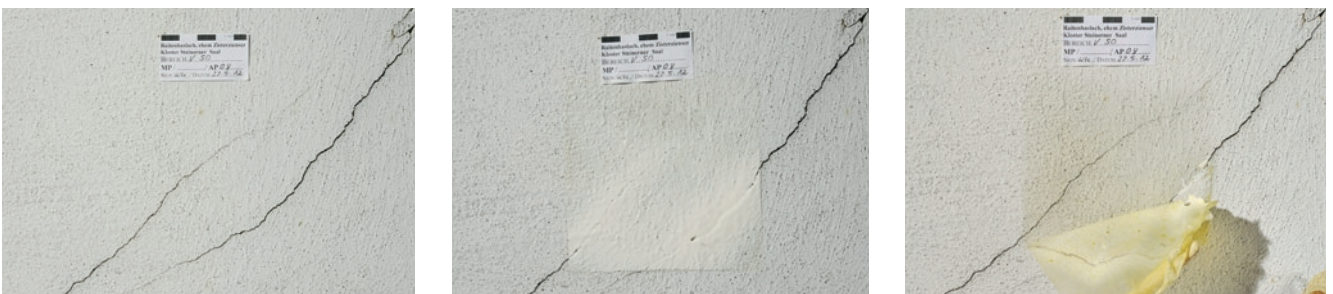
29–35. Arbeitsprobe 8, Bereich der Kehle Südost, Untergrund Holz-Spantenkonstruktion (von links nach rechts):
