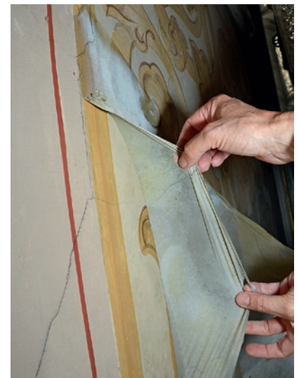
3–5. Ludwigskirche, südl. Querhauswand; links Musterfläche auf der Dekorationsmalerei der 1950er Jahre, Mitte und rechts Abnahme des Latexfilms auf instabiler Malschicht ohne Vorfestigung (Fotos: AG Restauratoren)
