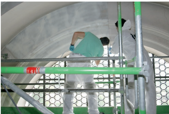
13. Aufsprühen des Films auf eine größere Fläche, nicht zu bearbeitende Bereiche werden abgedeckt.
