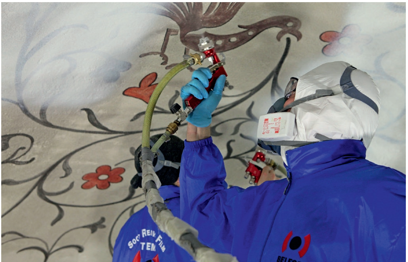
1. Koblenz, Herz-Jesu-Kirche; Anwendung des SRF im Niederdruckspritzverfahren (Foto: Belfor Europe GmbH)
