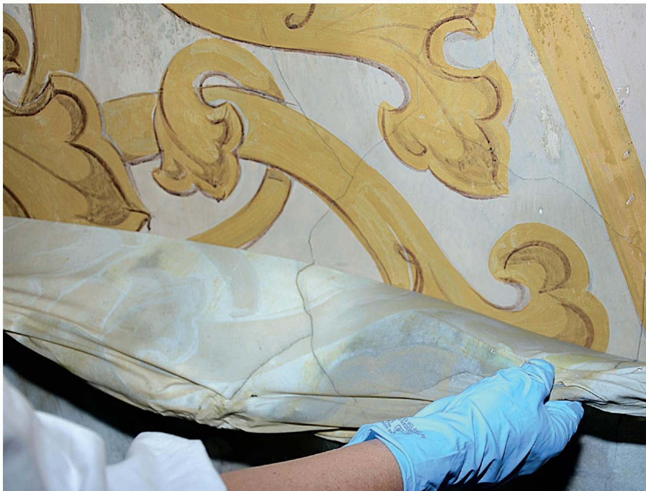
München, Ludwigskirche, südl. Querhauswand; Abnahme des Latexfilms SRF 2 NA nach ca. 4 Minuten Standzeit – vgl. S. 29, Abb. 5 bzw. S. 30, Abb. 6 (Foto: AG Restauratoren)
