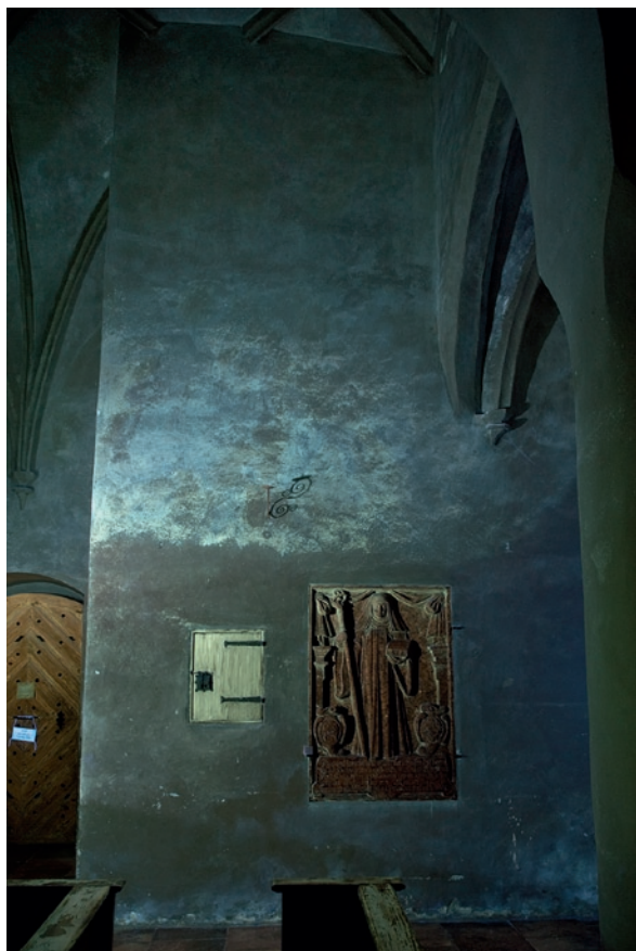
9. Südliches Seitenschiff, Nordwand des Aufgangs zur Orgelempore; UV-Fluoreszenzaufnahme der Musterfläche vor Beginn der Reinigung mittels SRF 2 NA, dunkel markiert eine Reparatur der Wandfassung im Sockelbereich, im normalen Licht kaum sichtbar
