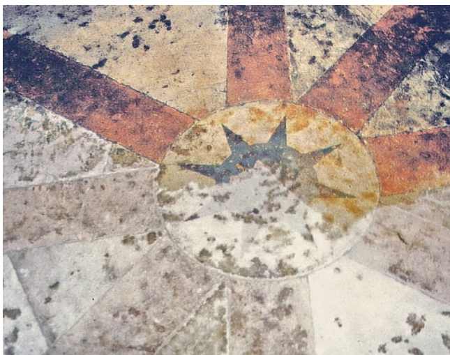
1. Landshut, St. Jodok, Sakristei; Detail des intarsierten Gipsestrichfußbodens (Foto: Klaus Klarner)
