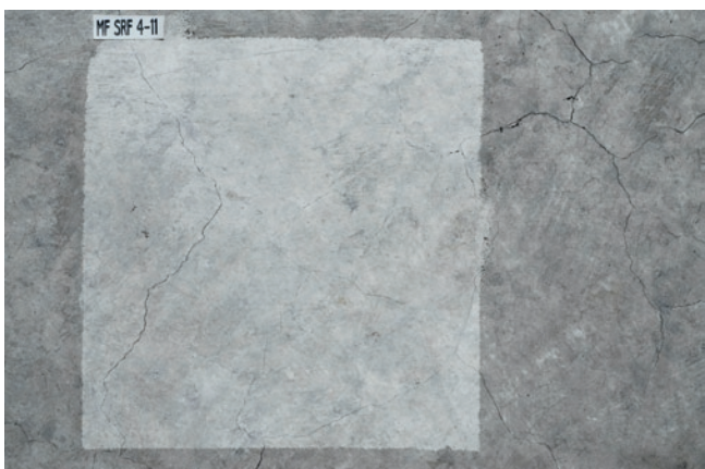
20. Musterfläche auf grauer Rücklage im Bereich des Chorstucks; sehr gutes Reinigungsergebnis, mit dem Film kann auch teilweise die Verschmutzung aus den Rissen entfernt werden
