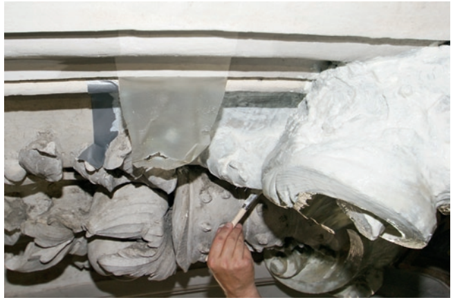
12. Alternativ kann der Naturkautschukfilm auch mit dem Silikon-Pinsel aufgetragen werden
