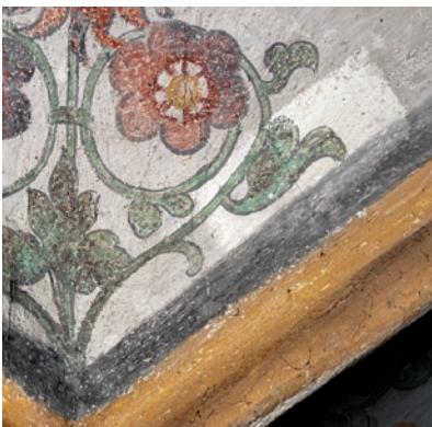
11. Gewölbeseigel im Süden der Orgelempore; Detail der Musterfläche für eine Latexfilm-Reinigung der Gewölbeflächen, Vorzustand (Juli 2012), sämtliche Konturen und ein Großteil der Rankenfüllungen entstammen der Restaurierung 1978, Staub überdeckt Fehlstellen
