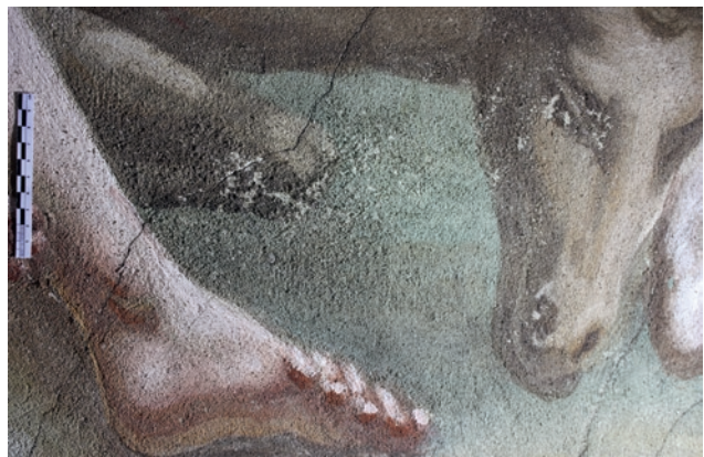
6a, b (Detail). Kehle Ost mit wasserschadensbedingten Putzausbrüchen
