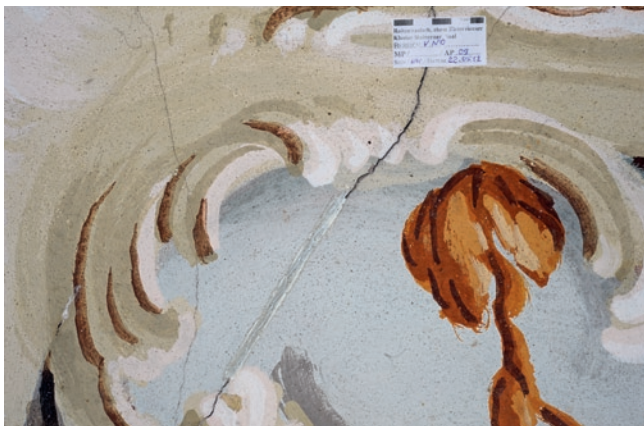
36–39. Arbeitsprobe 9, für eine Gegenprobe in der nordöstlichen Kehle wurde ein verschmutzter Riss ausgewählt (von links nach rechts): 36. Vorzustand; 37. Zwischenzustand mit Schablone zum begrenzten Auftrag des Latexfilms (nur im Riss); 38. Der feuchte Latexfilm über dem Riss; 39. Endzustand, auch bei begrenztem Latexauftrag und einer Auflagedauer von hier ca. 10 Minuten ergeben sich die gleichen durch Feuchtigkeit mobilisierten fluoreszierenden Auflagerungen (Fotos: Klaus Klarner)
