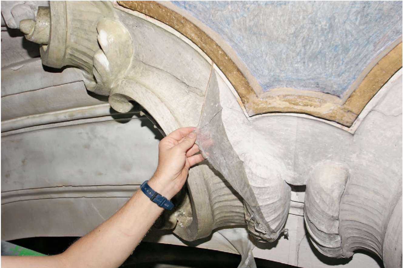
Murnau, St. Nikolaus; Abziehen des Latexfilms SRF 2 NA von gefasster Stuckplastik – vgl. S. 36 (Foto: Büro für Denkmalpflege, Utting)
