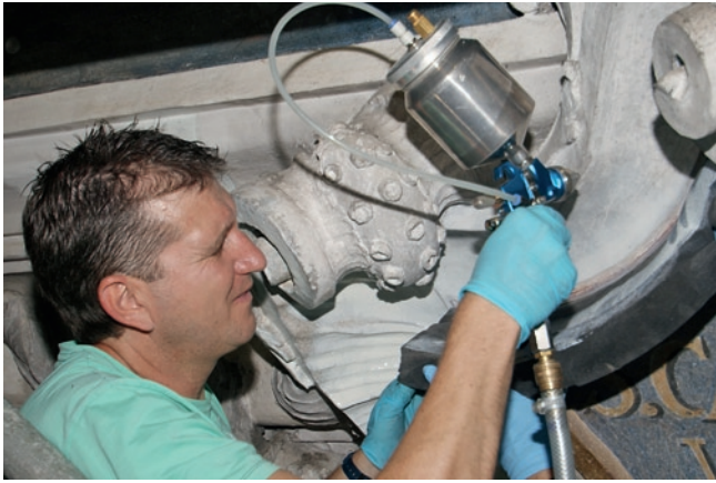
11. Aufsprühen des Naturkautschukfilms mit einer speziellen Druckluft-Sprühpistole
