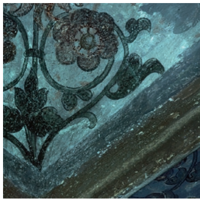
14. Gewölbekappe oberhalb der Orgel; erste kleine Arbeitsprobe für eine Reinigung mit SRF 2 NA, der augenscheinliche Reinigungserfolg entspricht den Vorstellungen, März 2012
