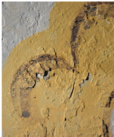
3–5. Ludwigskirche, südl. Querhauswand; links Musterfläche auf der Dekorationsmalerei der 1950er Jahre, Mitte und rechts Abnahme des Latexfilms auf instabiler Malschicht ohne Vorfestigung (Fotos: AG Restauratoren)
