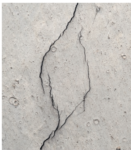
3. Südliches Seitenschiff, Westwand; Arbeitsprobe (Detail von Abb. 2) zur Oberflächenreinigung mittels aufgespritztem Latexfilm, Vorzustand
