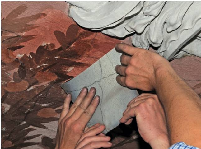
8. Malerei von 1934/35; Abziehvorgang von SRF 2 NA, sehr gutes Reinigungsergebnis, auch aus den Rissen werden die Rußablagerungen entfernt, 2012 (Foto: Michael Bengler)
