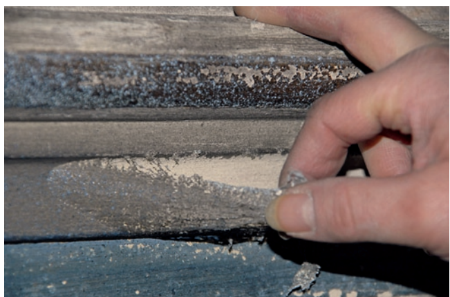
1a–c. Waiblingen, St. Nikolaus; Abnahme einer starken Verrußung auf pulverisierender Leimfarbenmalerei, Einwirkzeit ca. 20 Sek.
