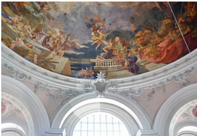
22a. Reinigungsfläche mit SRF im Kirchenschiff/Südseite; sehr gutes Reinigungsergebnis ohne weitere Reduzierung der Fassung
