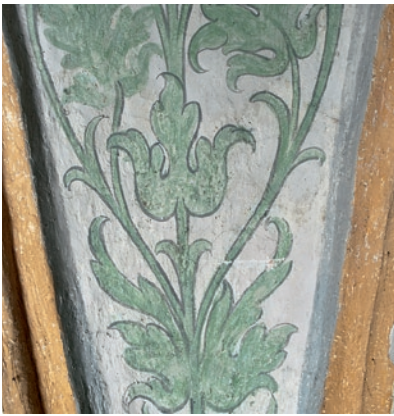
11. Gewölbeseigel im Süden der Orgelempore; Detail der Musterfläche für eine Latexfilm-Reinigung der Gewölbeflächen, Vorzustand (Juli 2012), sämtliche Konturen und ein Großteil der Rankenfüllungen entstammen der Restaurierung 1978, Staub überdeckt Fehlstellen
