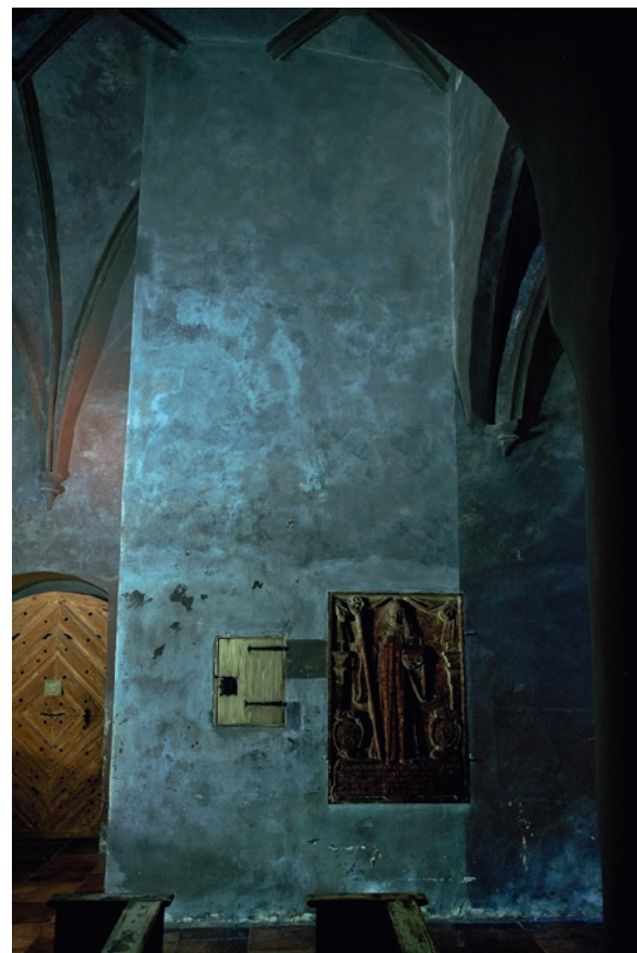
10. UV-Fluoreszenzaufnahme der Musterfläche nach der Reinigung mit SRF 2 NA, der Sockelbereich fluoresziert nun etwas heller als die darüberliegende Wandfläche, die insgesamt etwas heller erscheint (Fotos: Sven Oehmig)
