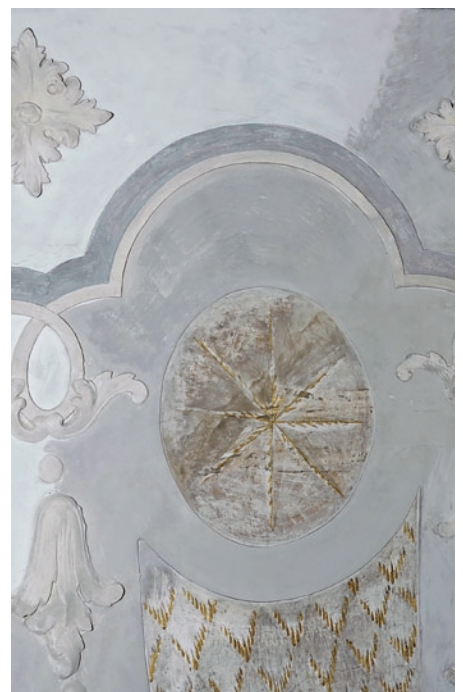
8. Detail der Gewölbefläche in der nördlichen Chorkapelle; Ausbesserungen, die vermutlich 2009 an die verschmutzte Oberfläche angepasst wurden, treten nach der Reinigung optisch auffällig hervor und verdeutlichen den starken Verschmutzungsgrad der Raumschale
