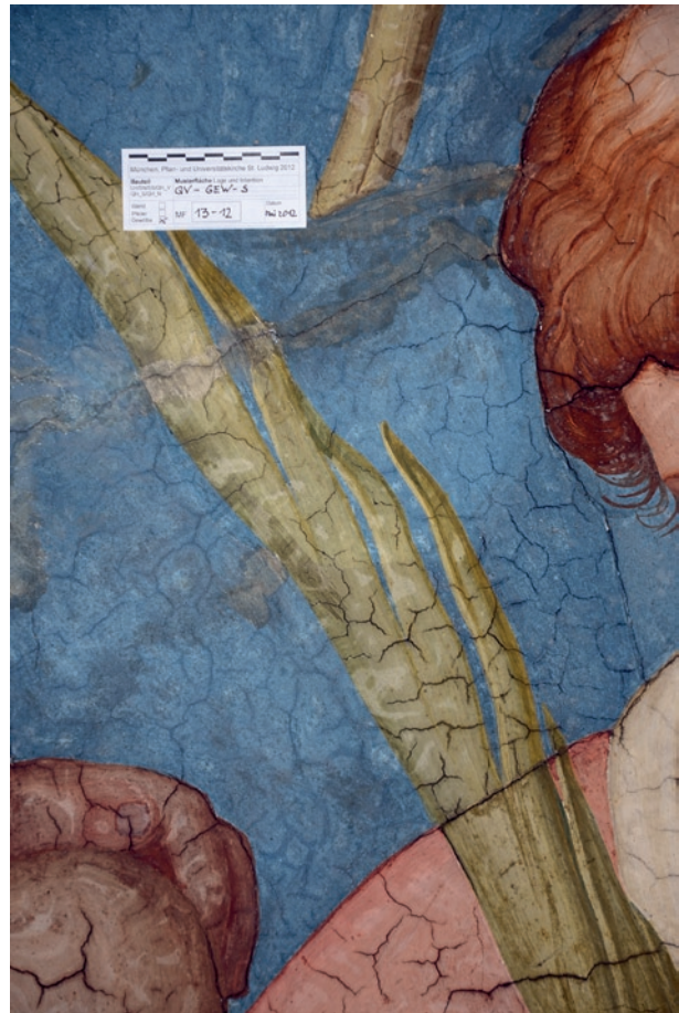
12a, b (Detail). Ludwigskirche, Vierungsgewölbe; Musterfläche im Fresko mit Risskittung und Übermalung (Fotos: AG Restauratoren)
