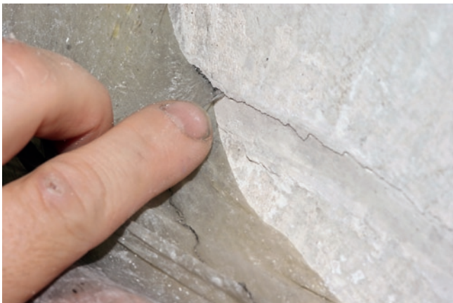
14. Abziehen des Films nach kurzer Standzeit, Schmutz wird auch aus den Rissen mit herausgezogen
