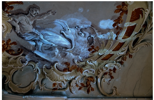
16, 17. Kehle Ost, auch alte, kaum sichtbare Wasserschadstellen werden in Form stark fluoreszierender Anlagerungen im UV-Licht sichtbar
