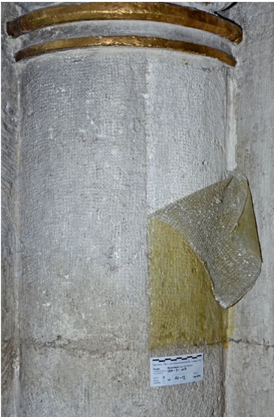
2. Ludwigskirche, südl. Querhaus; Musterfläche auf einer Natursteinsäule mit kompaktem Latexfilm (Foto: AG Restauratoren)
