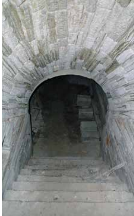
Bad Königshofen, Gipskeuper Tonnengewölbe der Poterne der Spitalbastion
