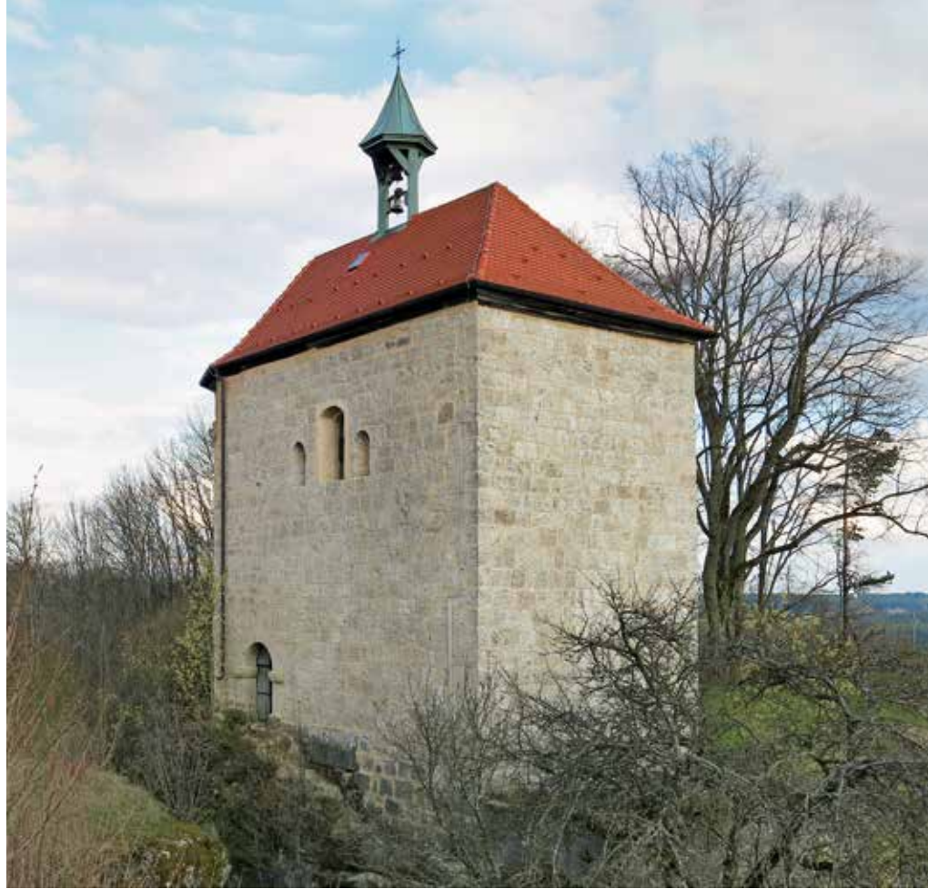
Blick vom nördlichen Burgfelsen auf die ehemalige Torkapelle. Links unten das Zugangsportal, davor der Felsspalt, über den eine Brücke zur stauferzeitlichen Burg hinüber führte (Foto: Johann Geitner)
