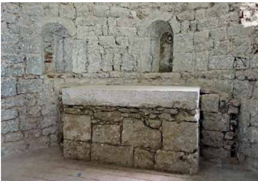
Die Apsis nach dem Abschlagen des Innenputzes. Am unterschiedlichen Steinmaterial lassen sich deutlich die ursprüngliche Höhe und die barocke Aufmauerung erkennen (Foto: Johann Geitner)
