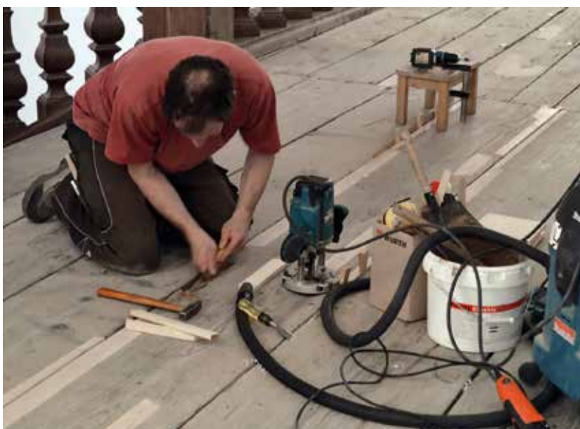
Restaurierungsarbeiten an den historischen Dielenböden im Flur des Prälatenstocks (Foto: BLfD, Paul Huber)
