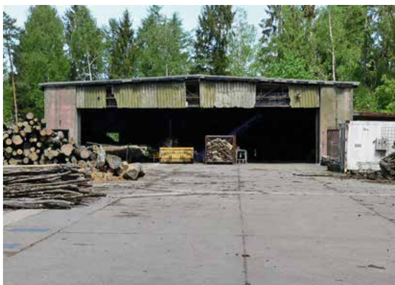
Mainbullau. Hangar H 1 (Raketen- und Sprengkopflager) von Süden mit betonierter Abschussfläche davor, 2015 (Foto: Privatarhiv Hermann Kerscher)
