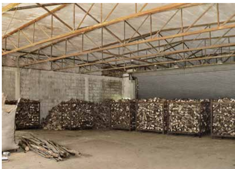
Mainbullau. Tragwerkskonstruktion des Daches von Hangar 1 und geschlossenes nördliches Rolltor von innen, 2015 (Foto: Privatarhiv Hermann Kerscher)
