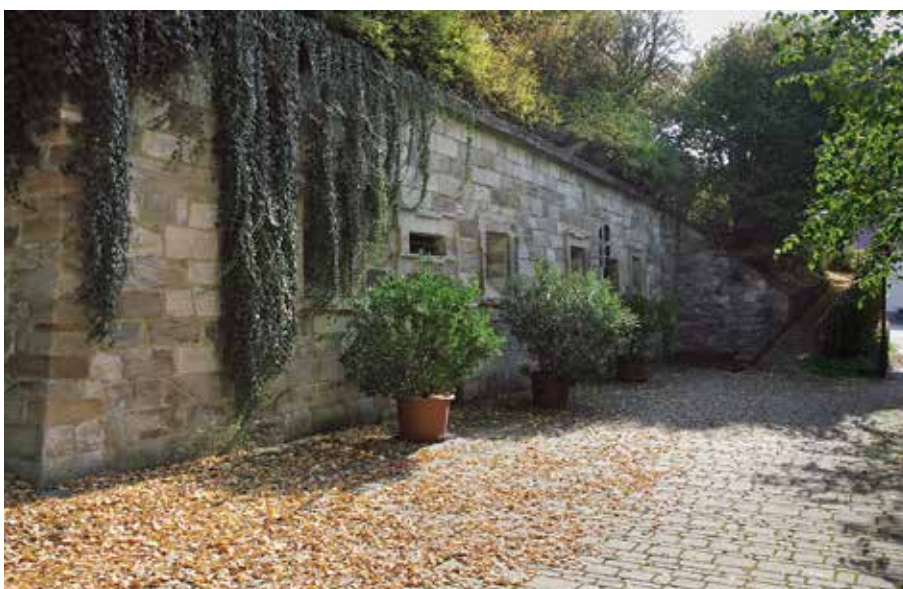
Bad Königshofen, Klosterbastion mit Zugängen zu den Magazinen und Zufahrtsrampe
