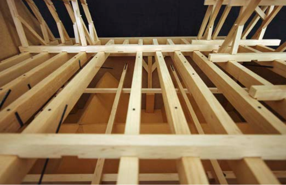
Ankersystem im Querhaus; oben links: Modell des Nordquerhauses mit den neuen Ankerbalken unter der Zerrbalkenlage; rechts: schmiedeeiserner Ankerkopf an der Außenmauer; unten: Schemaquerschnitt durch das Querhaus, Blick nach Westen, mit eingetragenen Sicherungen (farbig markiert)
