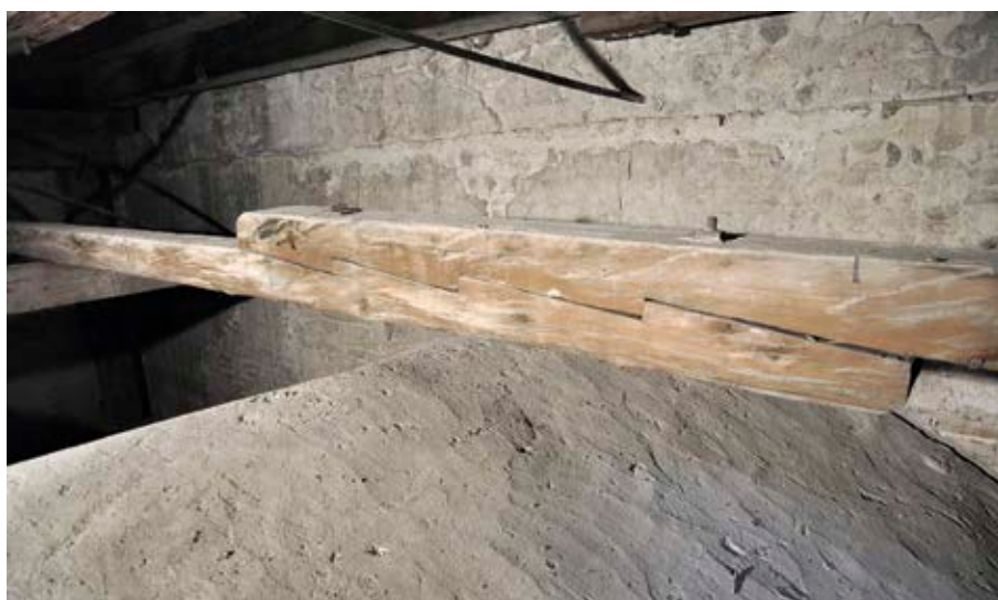
Stoß der Balkenabschnitte der in Nord-Süd-Richtung verlaufenden Anker, oben: Aufmaß, unten: Bestand
