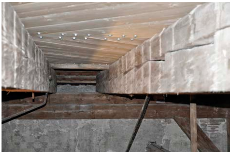
Erneuerter, verzahnter Zerrbalken im Nordquerhaus
