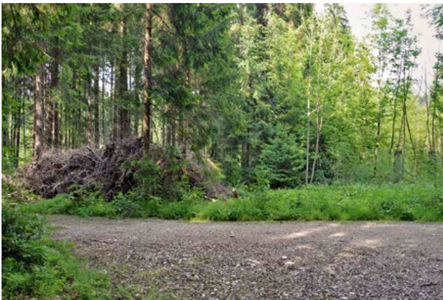
Fischen – Langenwanger Weidach, Südhalle der „Waldfabrik“. Im Eingangsbereich mit Waldabfällen zugeschoben, rechts im Hintergrund Betonpfeiler für das Dachtragwerk, Blick von Westen, 12. Juni 2017 (Foto: Archiv Markus Naumann)
