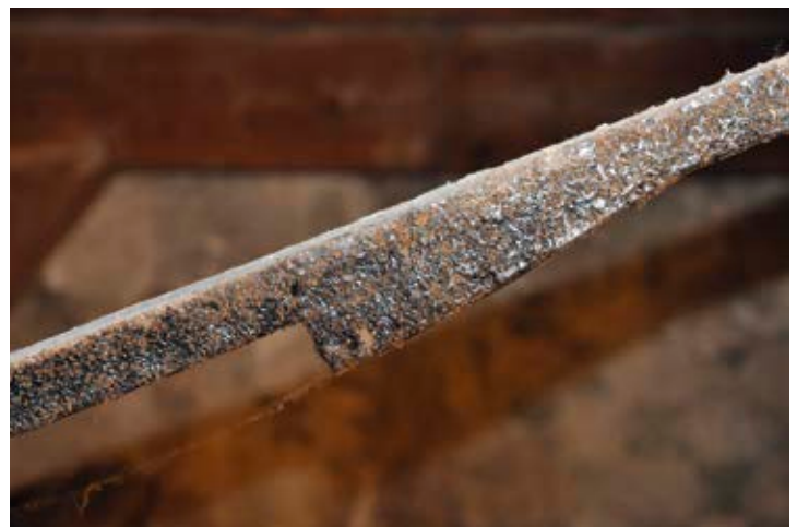
Aufgeschmiedeter Keil auf den Zugankern im Querhaus, vermutlich als „Greifhilfe“
