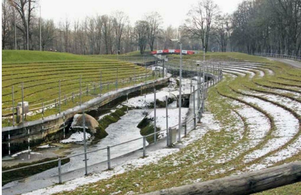
Augsburg, Kanustrecke. Der Kanal als erste betonierte Kunstrinne für Kanuwettbewerbe. Bei Niedrigwasser (Foto unten) sind die künstlichen Betonhindernisse gut zu erkennen (Fotos: BLfD, Harald Gieß)
