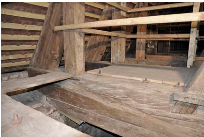
Zerrbalkenkopfreparatur an der Traufe des Langhausdachwerks, oben: Bestandsaufmaß, Mitte: Darstellung als Modell, unten: Bestand im Dachraum (Gespärre 6 Süd), rechts: Schemadarstellung der Zerrbalkenreparatur
