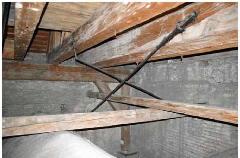
Nordwestecke des Querhauses, mit Abstützung der Zerrbalken vor der westlichen Außenmauer sowie den später eingezogenen Sicherungsbalken und schmiedeeisernen Ankern
