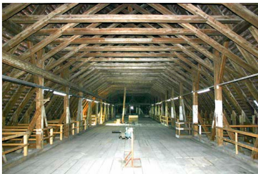
Blick von Osten in das Dachwerk über dem Langhaus (aufgehendes Dach inschriftlich 1483, Zerrbalkenlage dendrochronologisch 1178 datiert)
