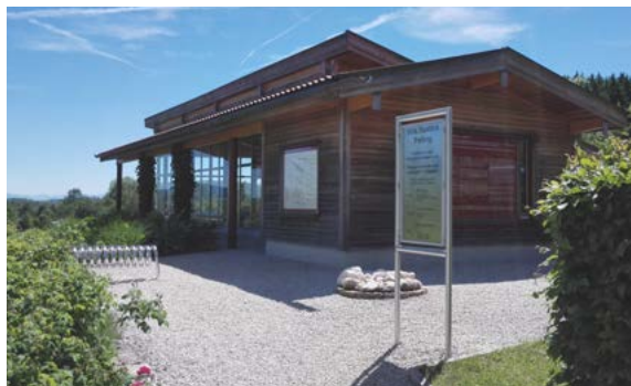
Oben & links: Schutzbau über den originalen Überresten des Gutshofs mit dem Lehrgarten im Vordergrund (Foto: Sabine Mayer)
