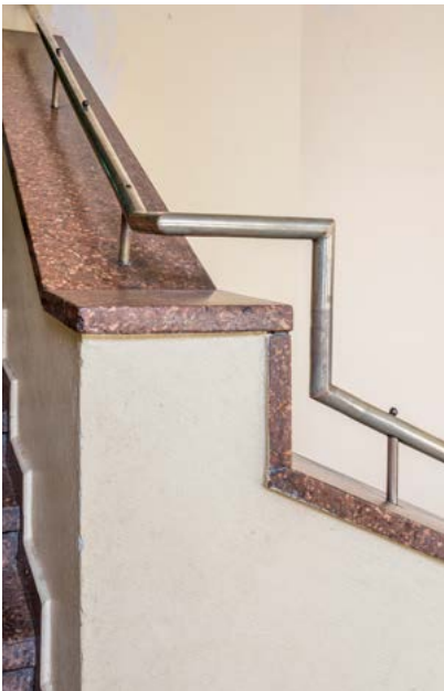
Neben runden sind auch gezackte Formen wie der mehrfach gewinkelte Messinghandlauf eine charakteristische Spielart expressionistischer Details; dabei kontrastiert das runde Metall stilischer mit den kantigen Terrazzoplaten auf der Brüstungsmauer.
