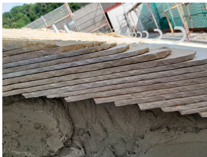
Oben und links: Erneuerung eines Kalkplattendaches in Kinding (Lkr. Eichstätt). Die Platten sind hell und noch nicht bewittert. Nach kurzer Zeit werden sie grau. (Fotos: Stefan Ziegler)
