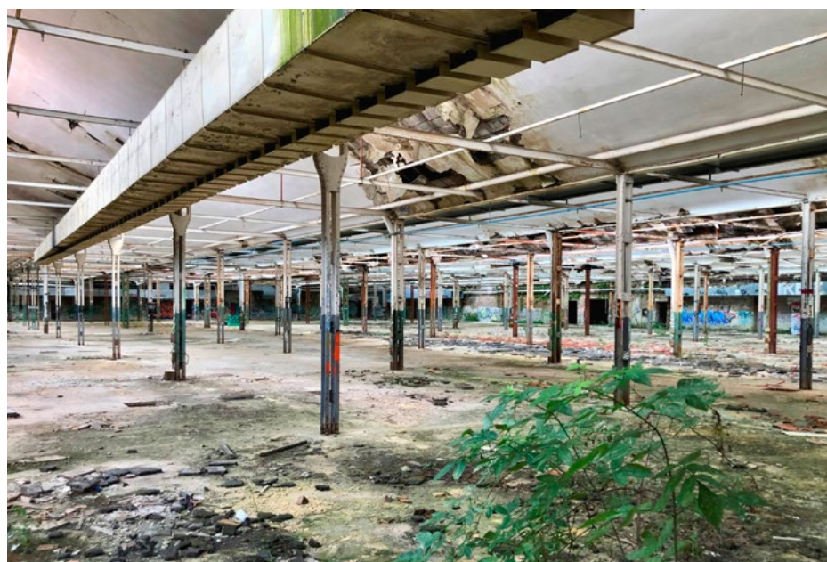
Oben: Wohnhaus, 18. Jh., Mittelfranken (Foto: Tobias Pretscher); rechts: Webereihalle, 1908, Schwaben (Foto: BLfD, Tobias Bösl)
