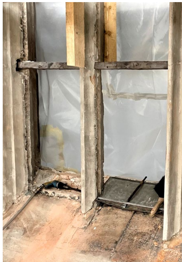
Deutlich sind hier die geringen Durchmesser der Sandsteinstreben erkennbar. (Foto: BLfD, Kerstin Brendel)
