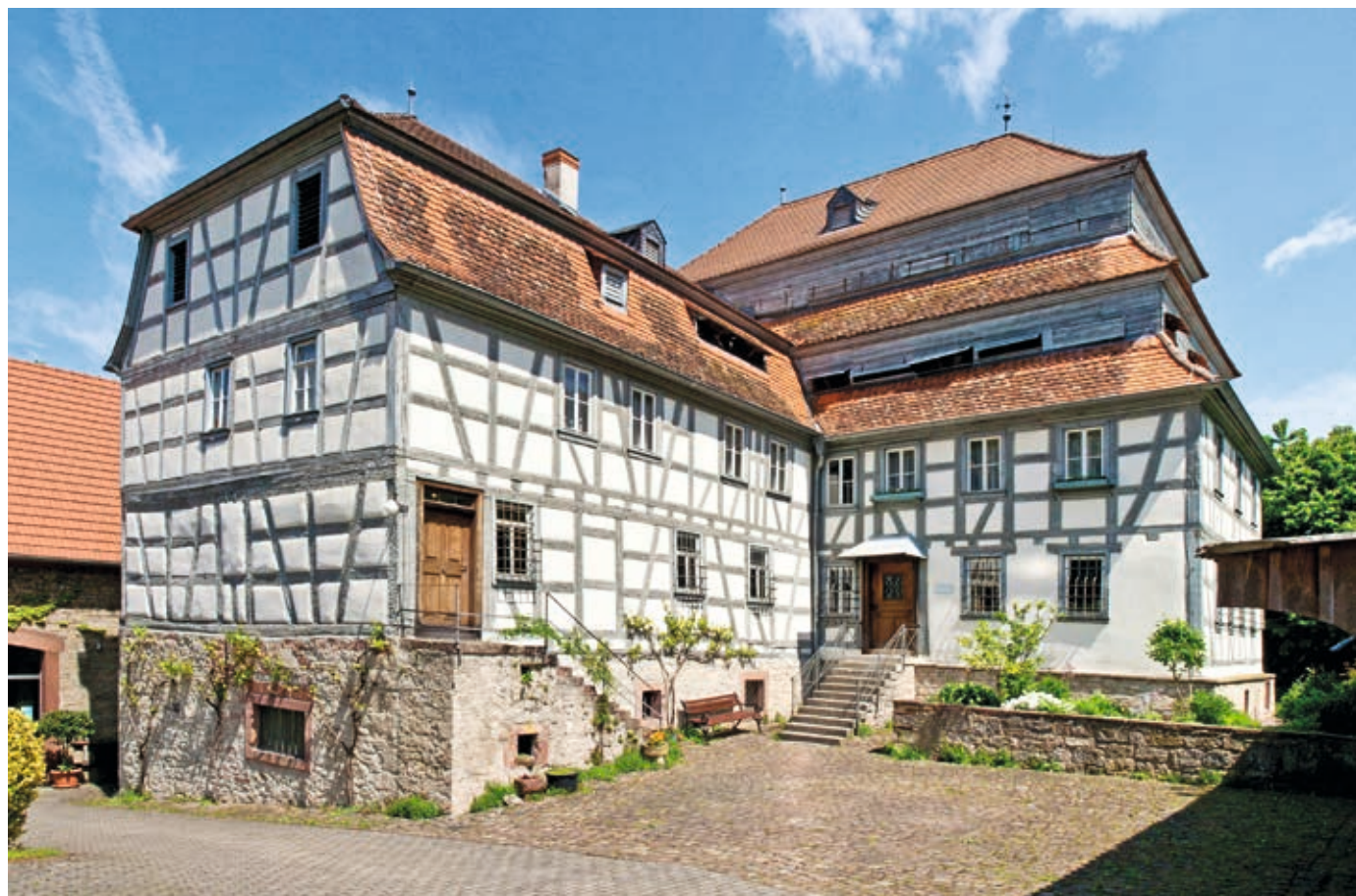
Papiermühle in Homburg am Main, Westansicht (Foto: Landratsamt Main-Spessart, Oliver Wieser, 2012)
