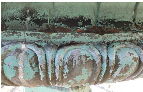
5 Verwitterte Oberfläche der Brunnenbecken. Foto:BLfD
