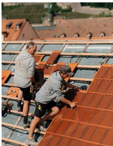
Dachdeckung des Klosters der Erlörschwestern in Würzburg. ©Matthias Hofner.
