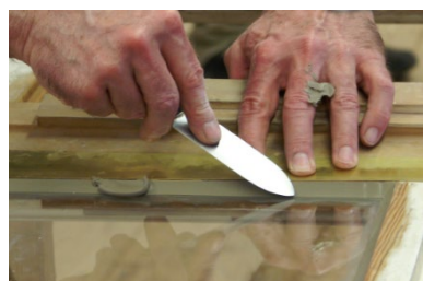
Einkitten von Glas, Fotos: BLfD
