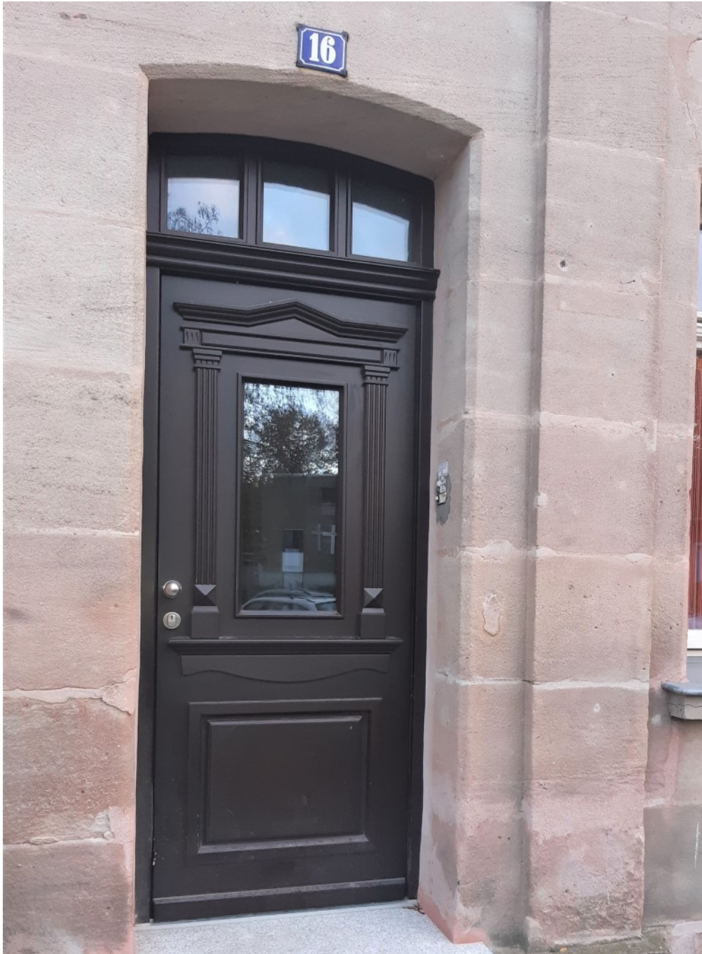
© (H. Richter) Sanierte Eingangstür
