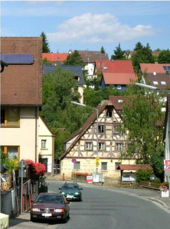
© (BLfD) Ortsbildprägendes Baudenkmal
