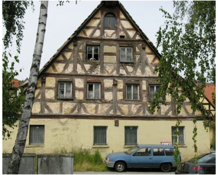
© (BLfD) Malerisches Fachwerkhaus des 18. Jh.
