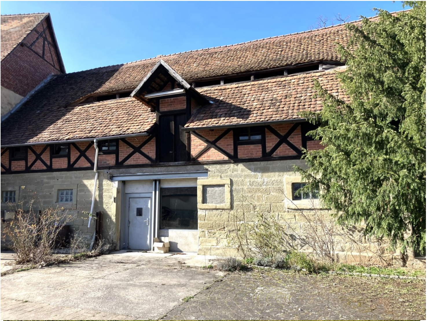
© (G. Gronauer) Ansprechendes Stallgebäude aus Quadermauerwerk mit Fachwerkkniestock
