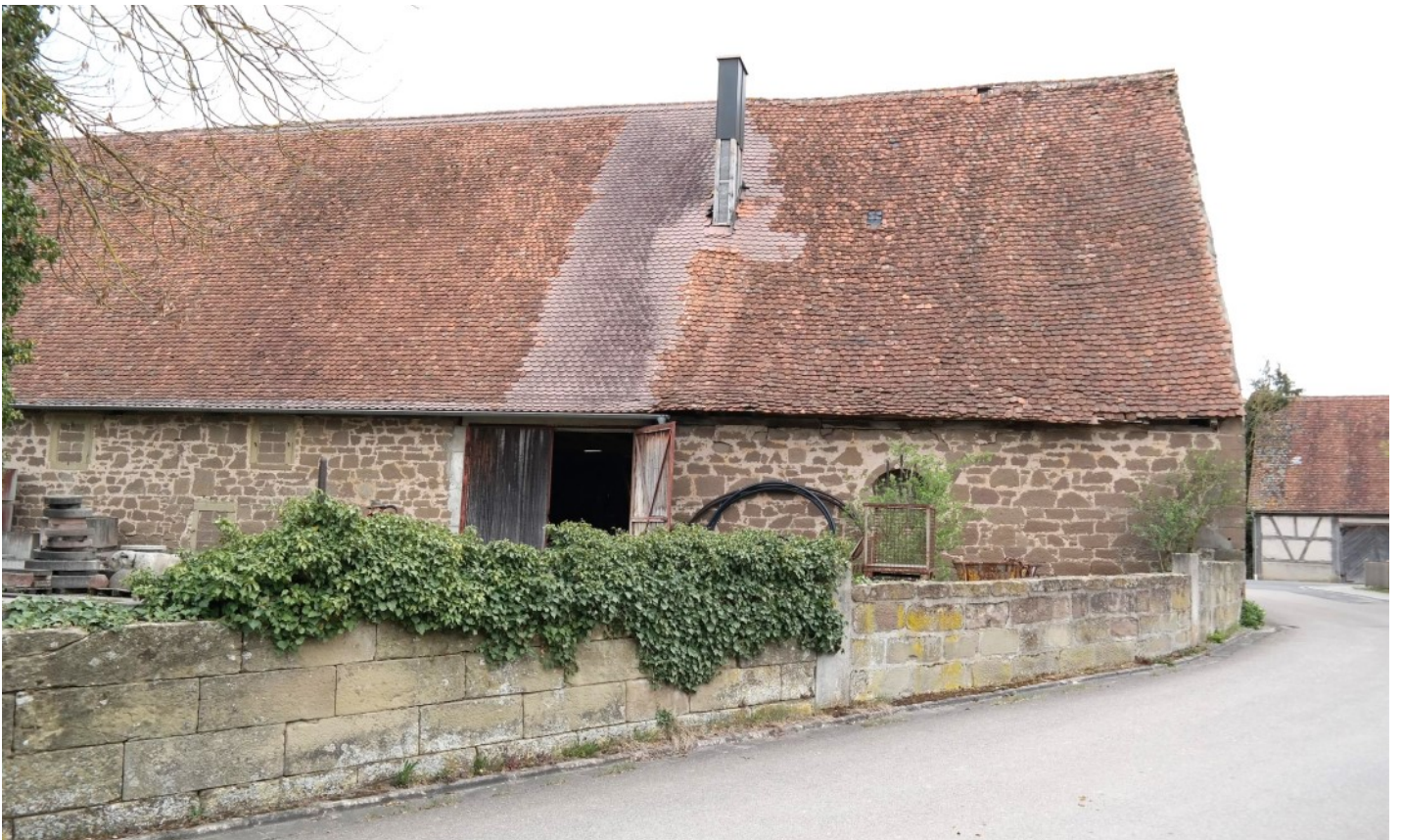
© (BLfD) Aus Bruchsteinmauerwerk errichtetes Wirtschaftsgebäude
