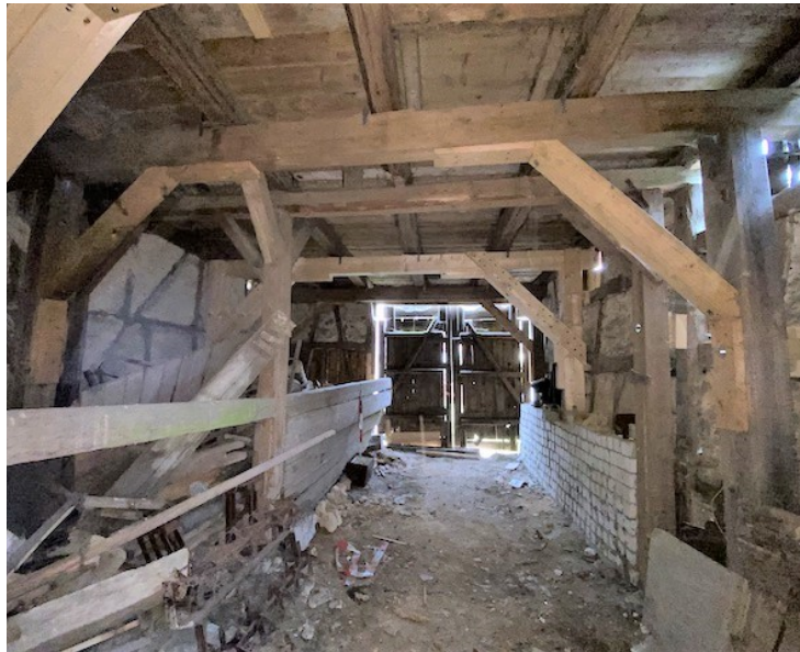
© (F. Noll) Eingangsbereich der Fachwerkscheune
