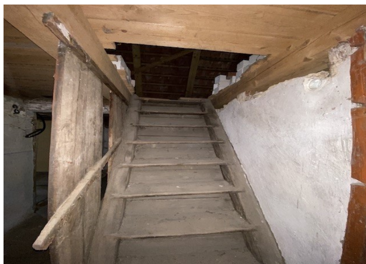
© (F. Noll) Treppenaufgang ins OG
