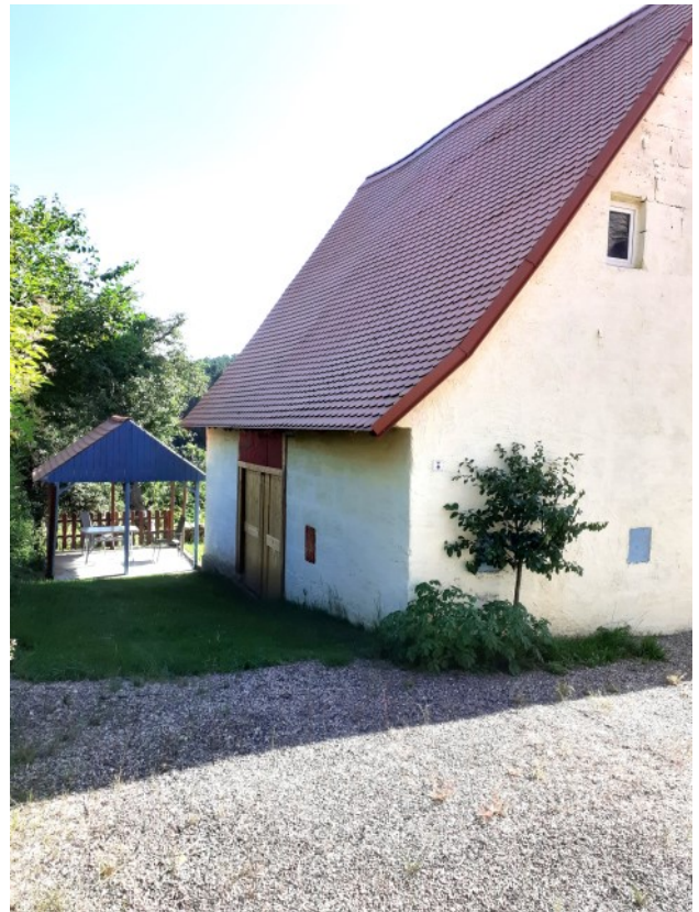
© (E. d. A.) Verputzte Sandsteinscheune
