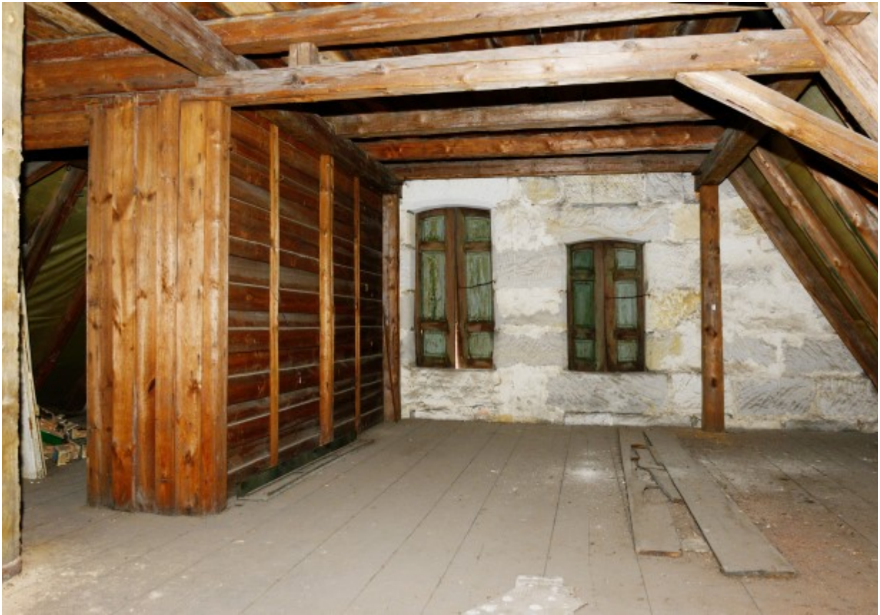
© (S. Weckmar) Dachgeschossbereich des Bauernhauses
