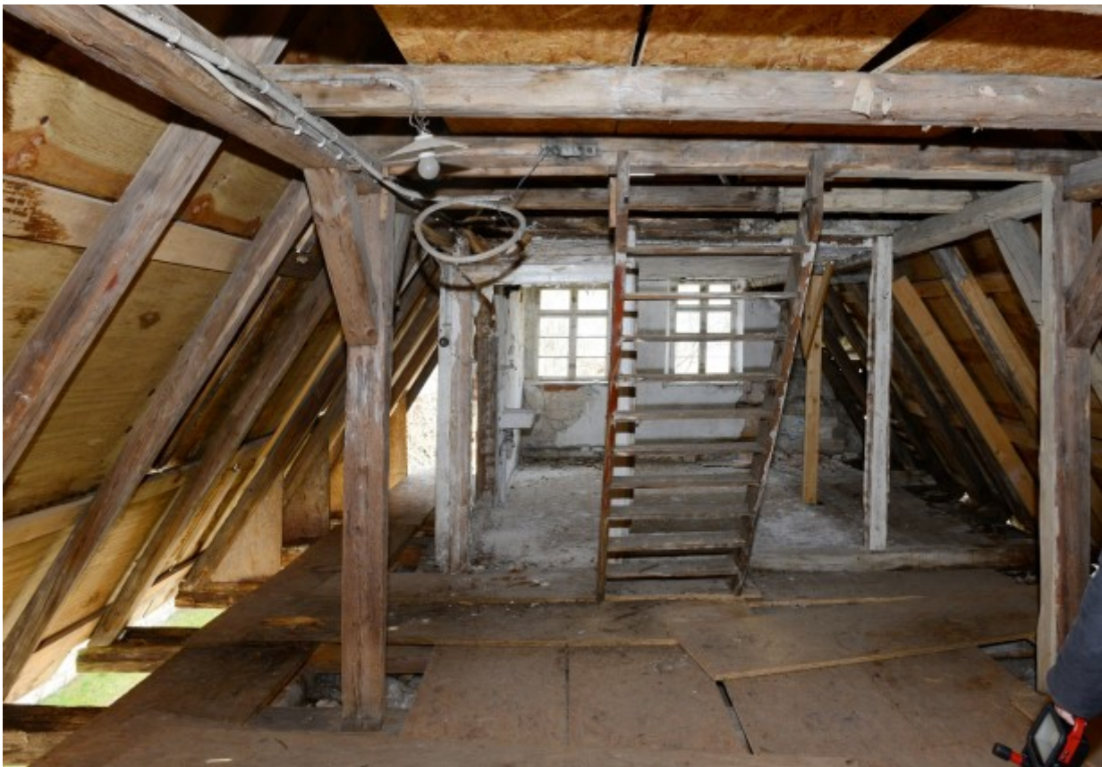
© (S. Weckmar) Dachboden des Stallgebäudes
