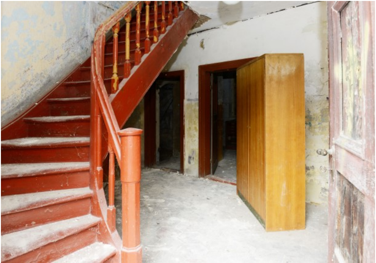
© (S. Weckmar) Eingangsbereich mit Treppenaufgang ins OG
