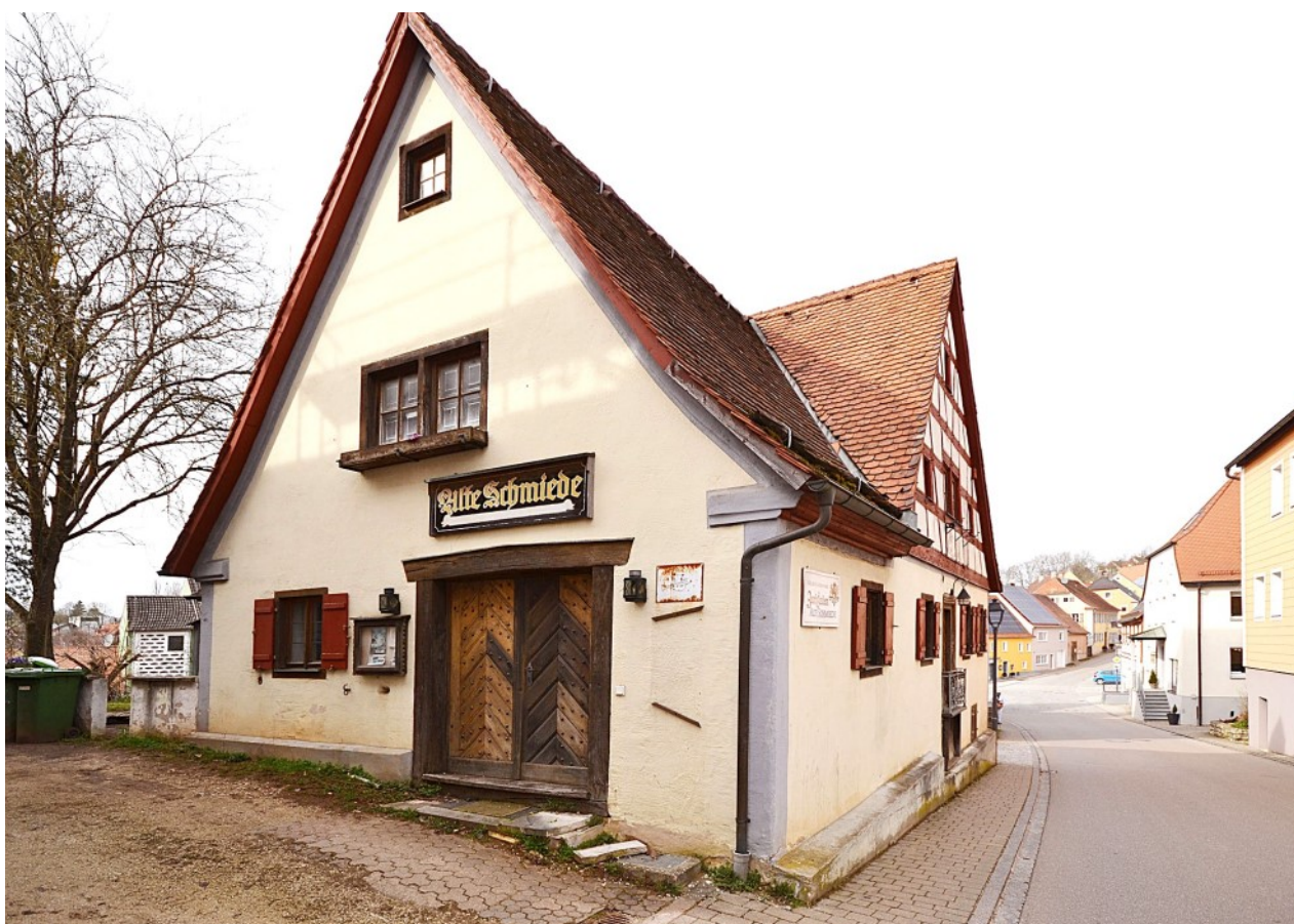
© (S. Weckmar) Das Gasthaus „Alte Schmiede“
