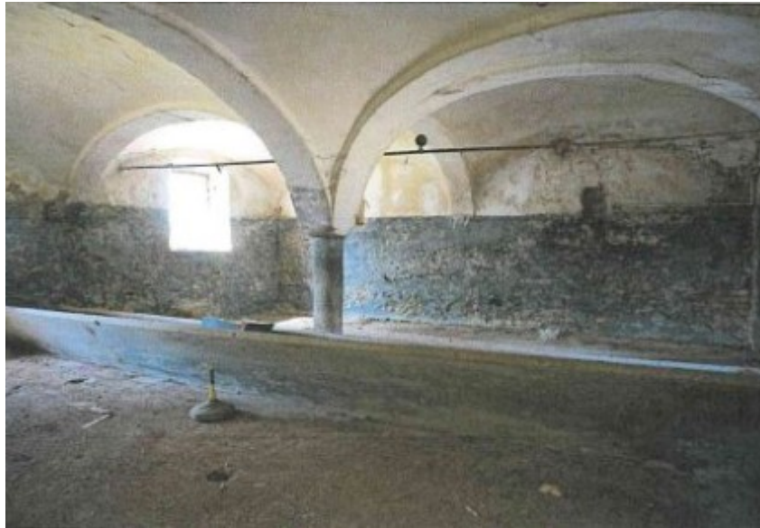
© (Gde. Loiching) Gewölbe auf Granitsäulen gestützt
