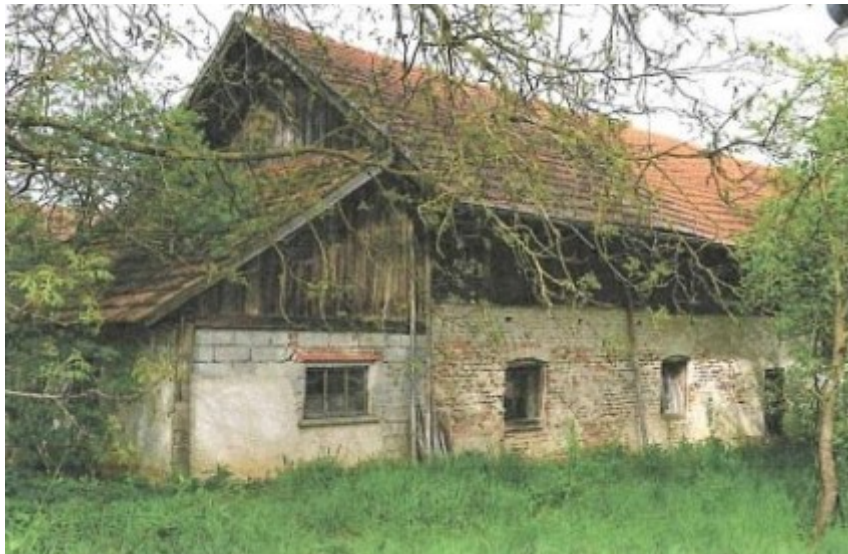
© (Gde. Loiching) Stallgebäude von der Südwestseite
