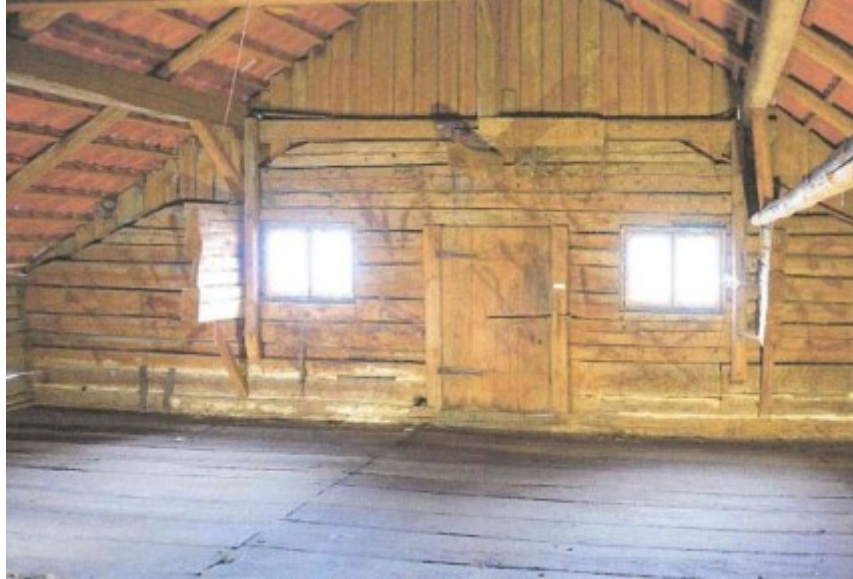
© (Gde. Loiching) Dachboden des Bauernhauses
