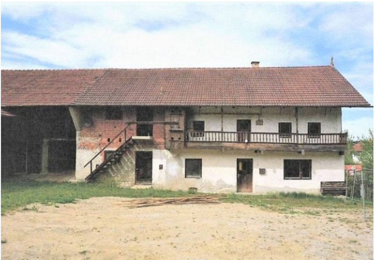
© (Gde. Loiching) Beachtliches Bauernhaus mit denkmalgeschütztem Wohnteil
