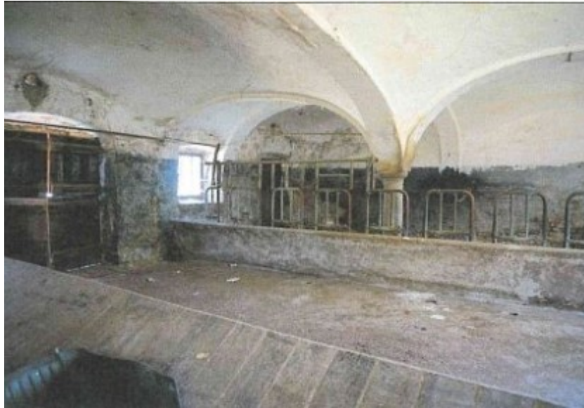
© (Gde. Loiching) Böhmisches Kappengewölbe im Stall
