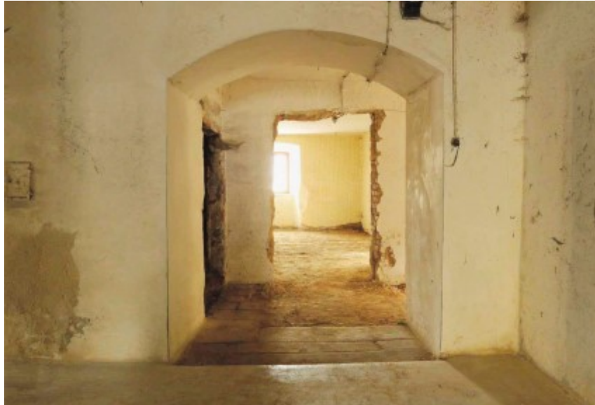
© (D. Härle) Wohnräume mit Rundbögen im Rohbauzustand
