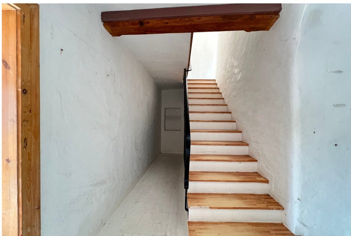
Treppenaufgang + Zugang zum Keller
