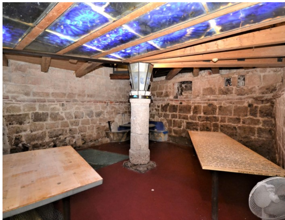
© (G. Gronauer) Außergewöhnlicher Gastraum in mittelalterlichen Mauern
