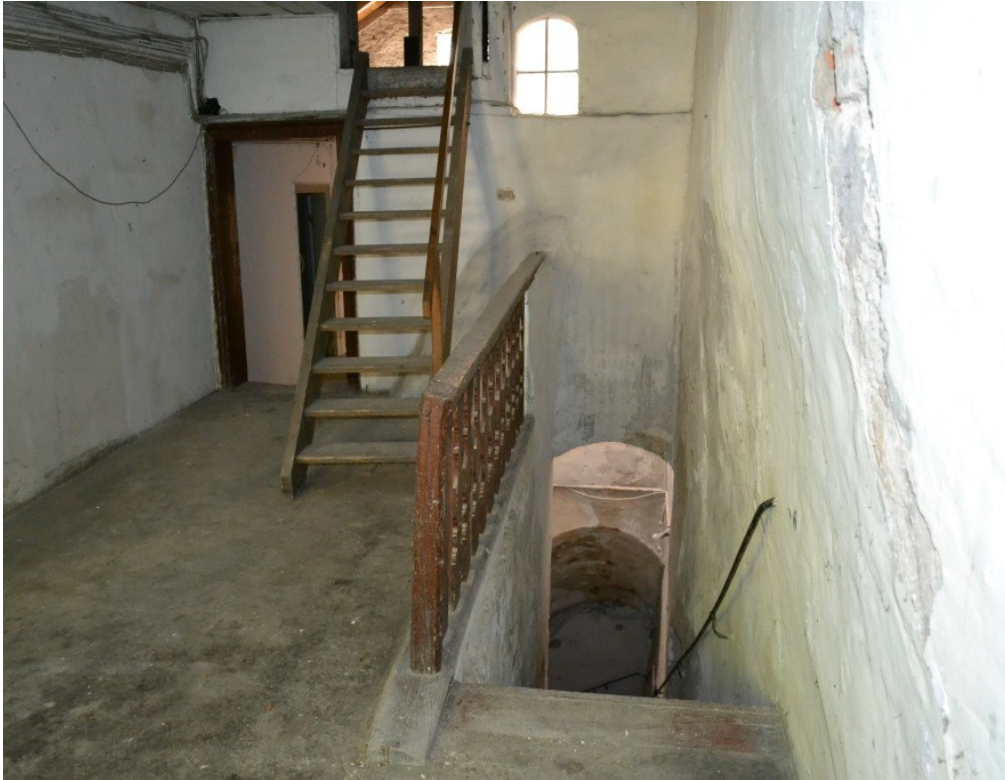
© (W. Ritter) Zugang zu den oberen Etagen
