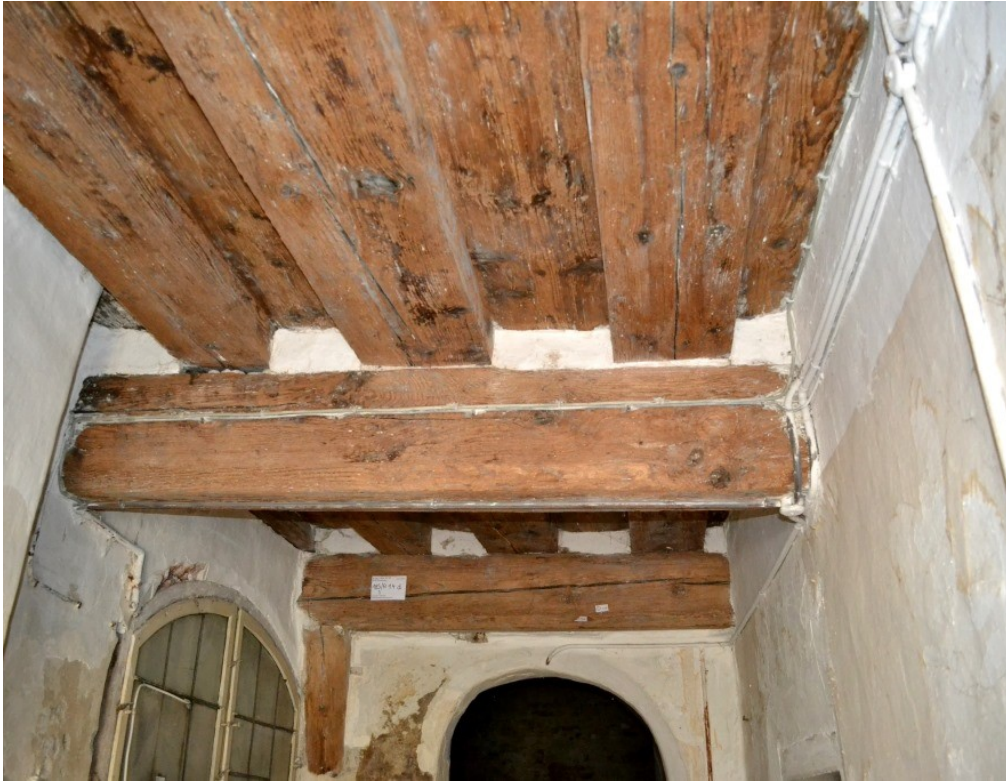
© (W. Ritter) Historische Bohlenbalkendecke
