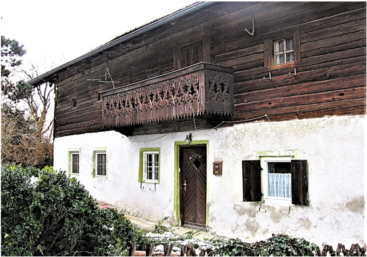
© (Ch. Sinzinger) Bauernhaus mit massivem Erd- und Blockbau-Obergeschoss
