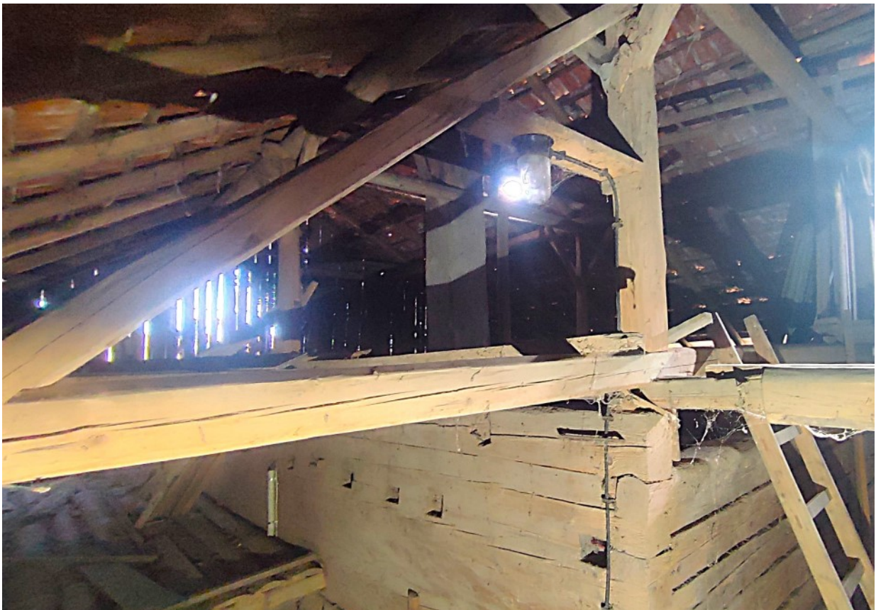
© (Ch. Sinzinger) Historischer Dachbereich
