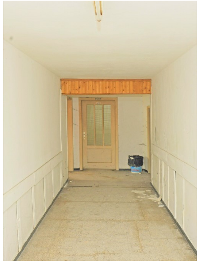
© (G. Gronauer) Großzügiger Flurbereich
