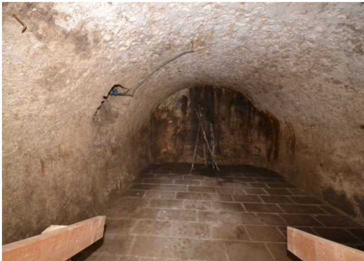
© (G. Gronauer) Großzügiger Gewölbekeller
