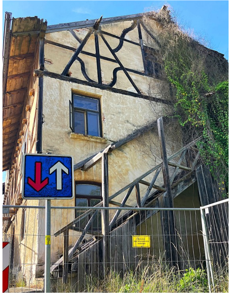
© (Die Denkmalschutz Immobilie) Außentreppe ins OG
