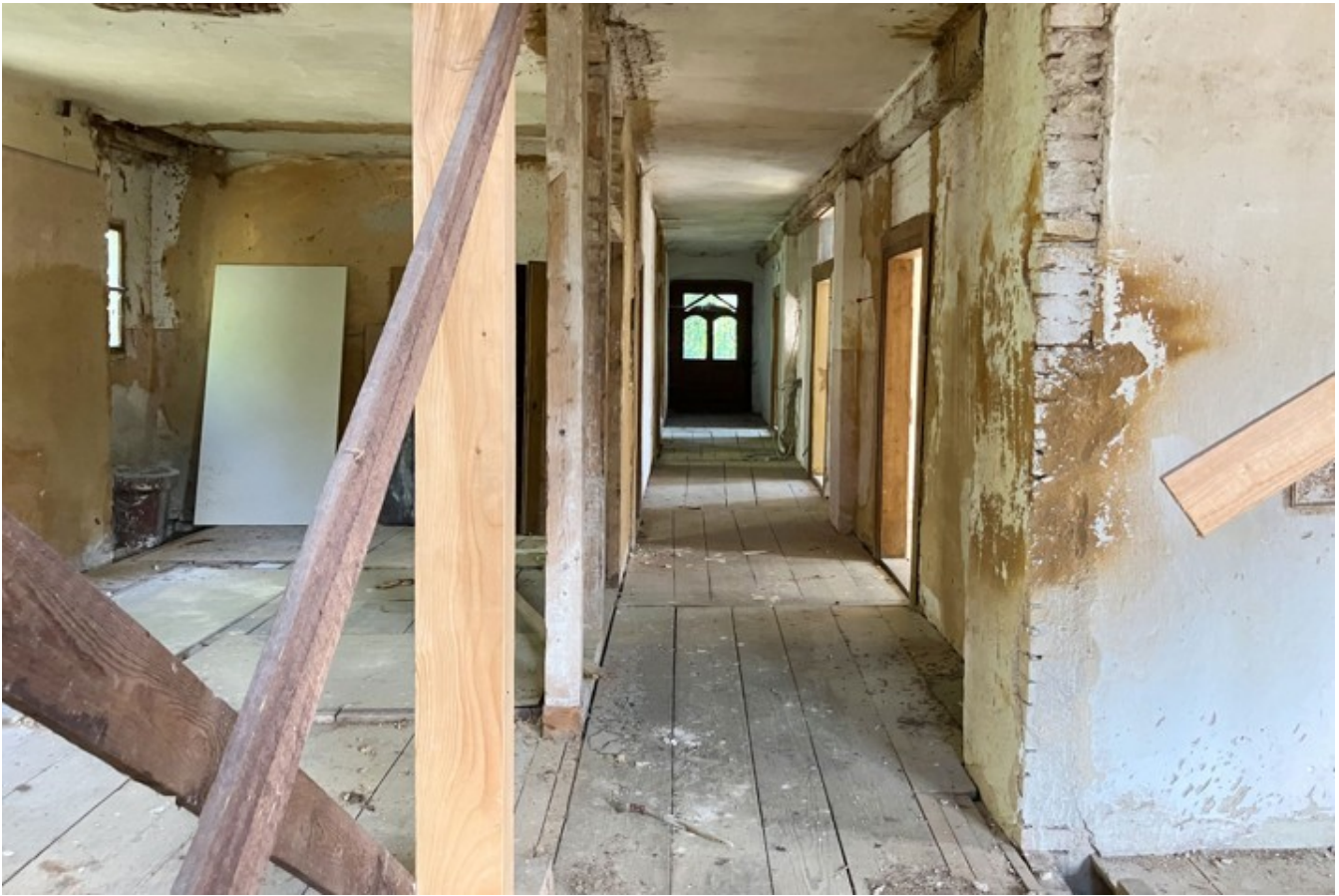
© (Die Denkmalschutz Immobilie) Flurbereich im OG und Zugang zu 6 Wohnräumen
