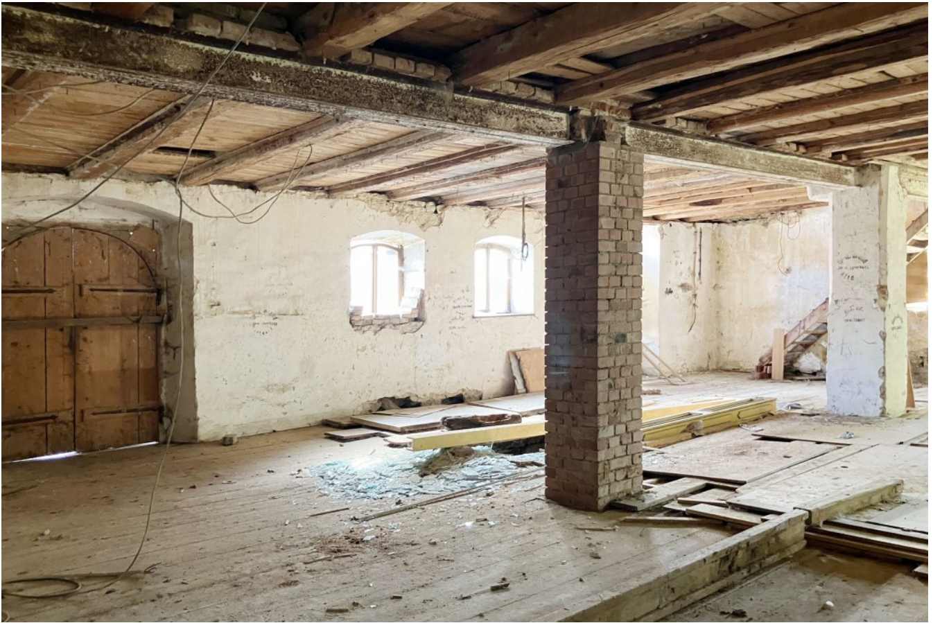
© (Die Denkmalschutz Immobilie) Großzügiger Wirtschaftsraum im EG
