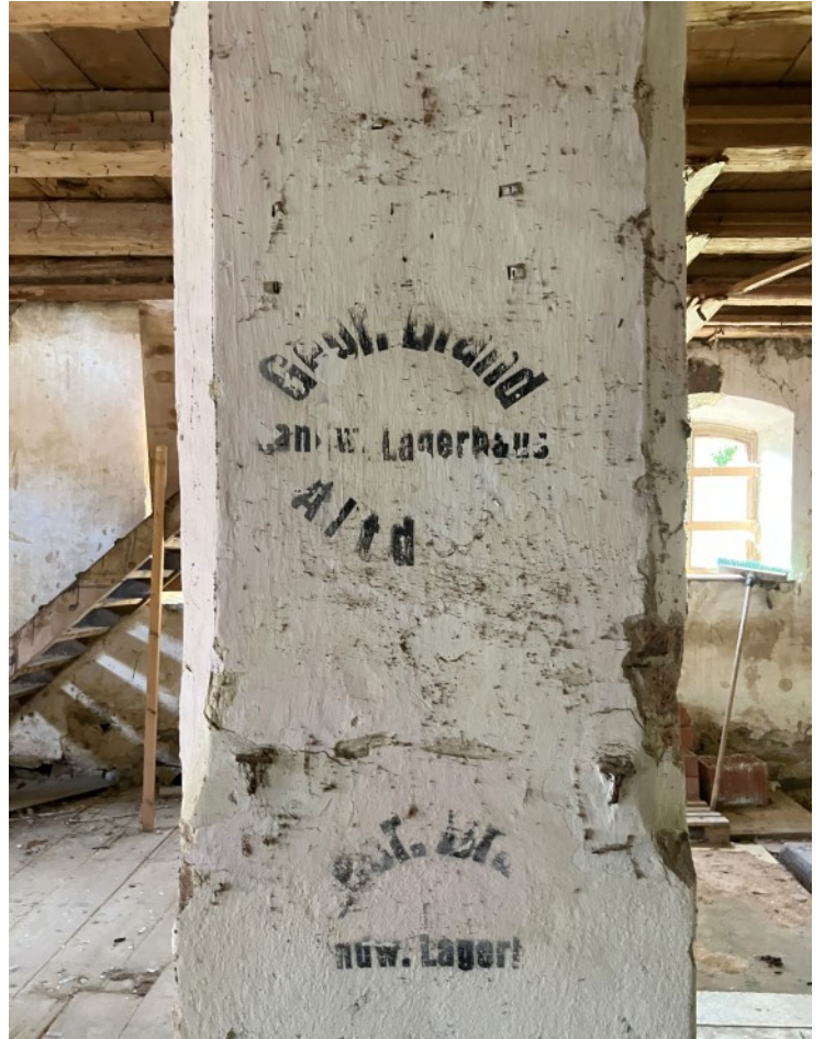
© (Die Denkmalschutz Immobilie) Pfeiler mit historischer Aufschrift
