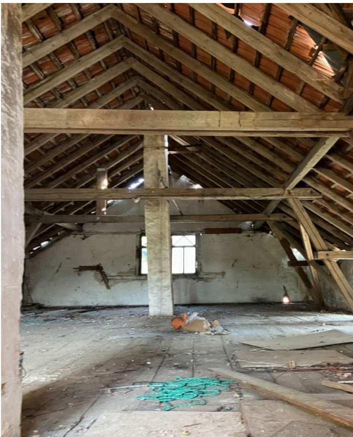
© (Die Denkmalschutz Immobilie) Beachtlicher Dachbereich
