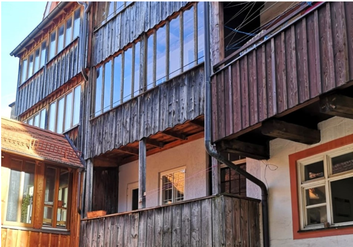
© (K. Hartmann) Reizende Holzaltane an der Gebäuderückseite
