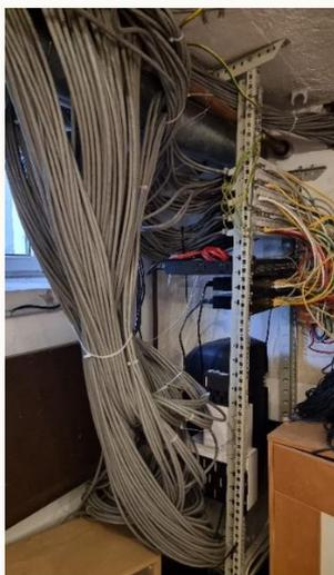
Die CAT5e Kabel sammeln sich alle im Keller im mittleren Zimmer (Musik-Proberaum) in der hinteren rechten Ecke. Die Verteilung erfolgt über ein an der Decke aufgehängtes offenes 19 Zoll Rack. Die Kabel haben Überlänge, um eine Unterputz-Verlegung zu ermöglichen.
