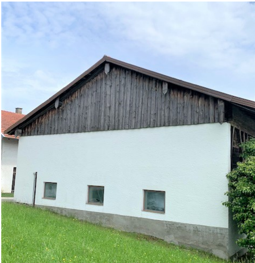
© (H. Kürmayer) Erneuerter Giebel an der Westseite
