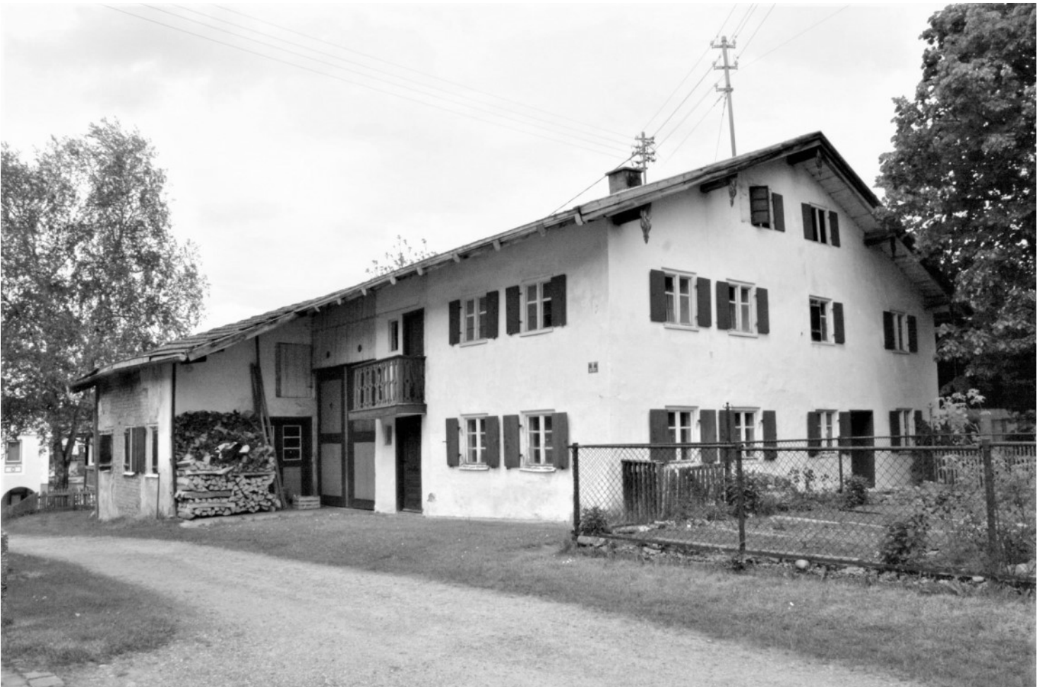
© (BLfD) Historische Aufnahme des traditionellen Einfirsthofs mit Wohnteil, Mittertenne und Hakenschoopf
