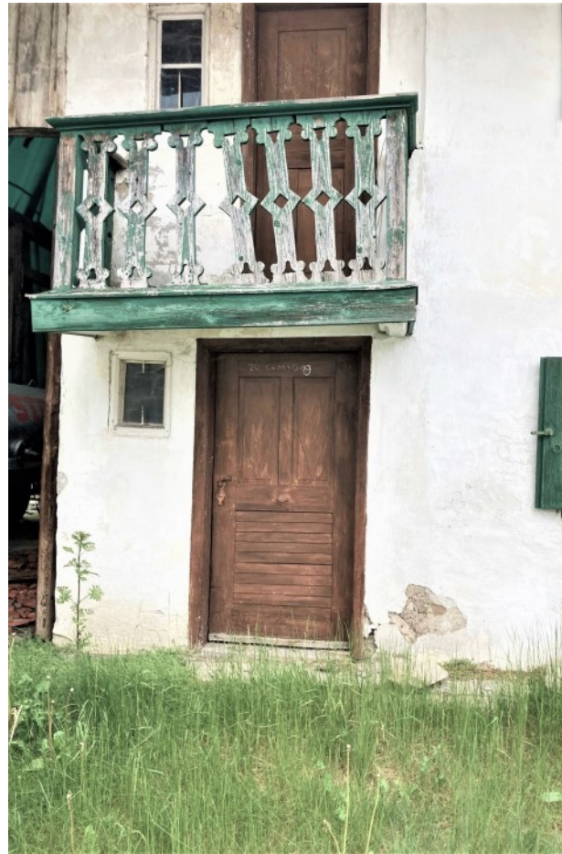
© (E. d. A.) Haupteingang mit darüber liegendem Balkon
