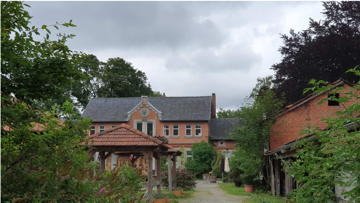
Ansicht Hauptgebäude D und Handwerkergebäude (Die Pavillons wurden mittlerweile entfernt).
