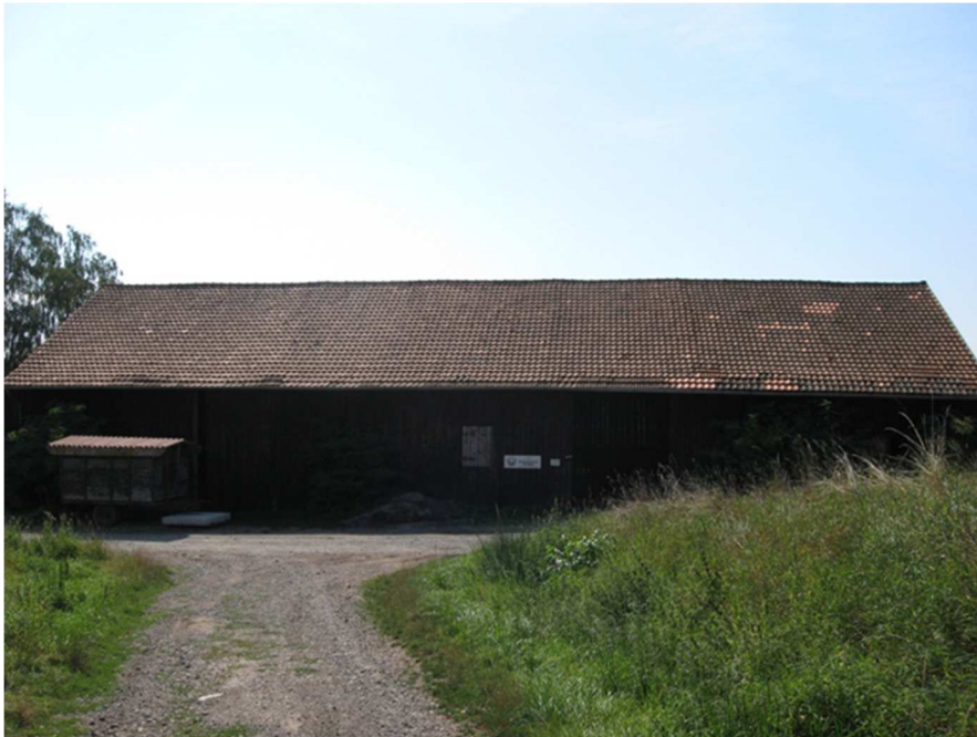
Blick auf Nordseite von Nebengebäude F
