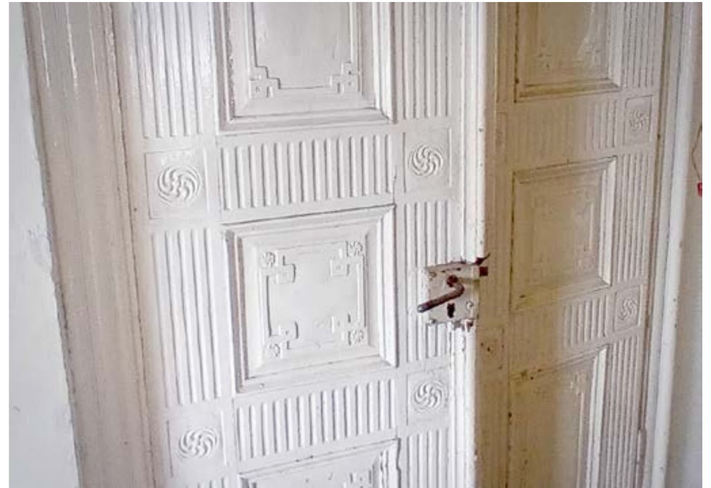
Abb. 9 zweiflügelige, geschnitzte Türe im Obergeschoss
