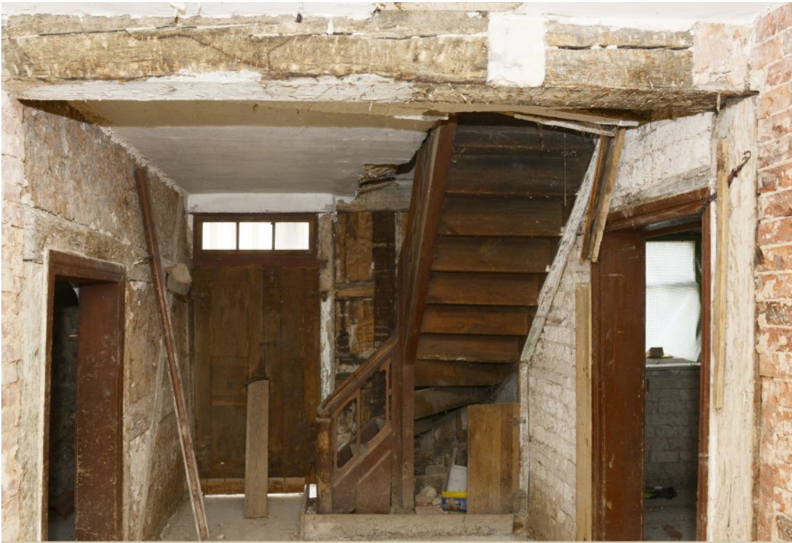
© (G. Gronauer) Eingang, Flur und historische Treppe ins OG
