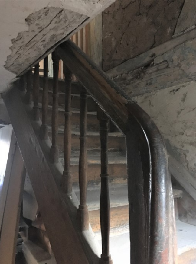
© (BLfD) Treppe ins OG
