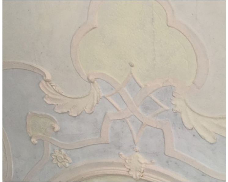
© (BLfD) Eindrucksvolle Stuckdecke im OG
