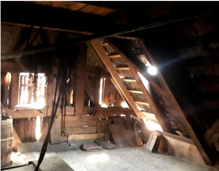
© (BLfD) Großzügiger Dachbereich
