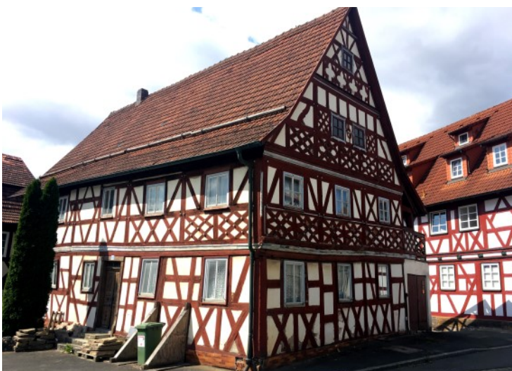
© (BLfD) Historisches Wohnhaus des 18. Jh.
