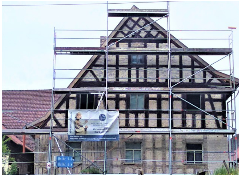
© (E.d.A.) Sanierung der Fassade
