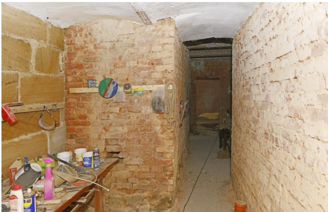
© (G. Gronauer) Wohnraum mit Gewölbe im EG
