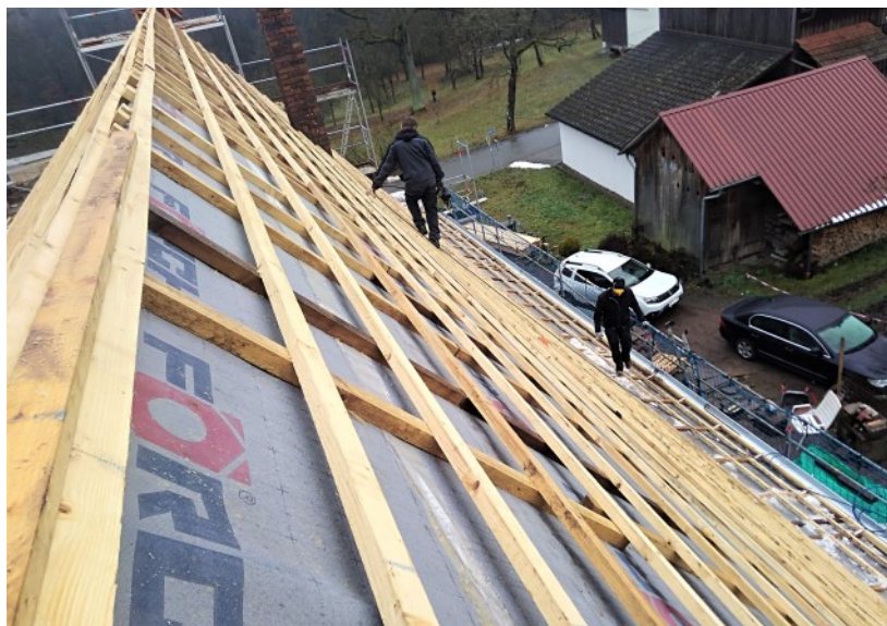
© (E.d.A.) Sanierungsarbeiten am Dach
