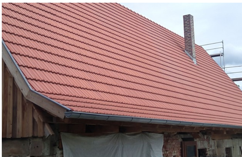
© (E.d.A.) Neueingedecktes Dach
