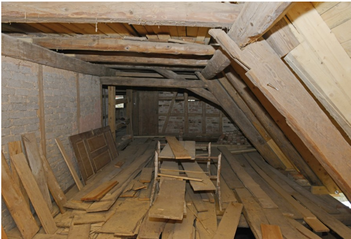
© (G. Gronauer) Großzügiger Dachbereich
