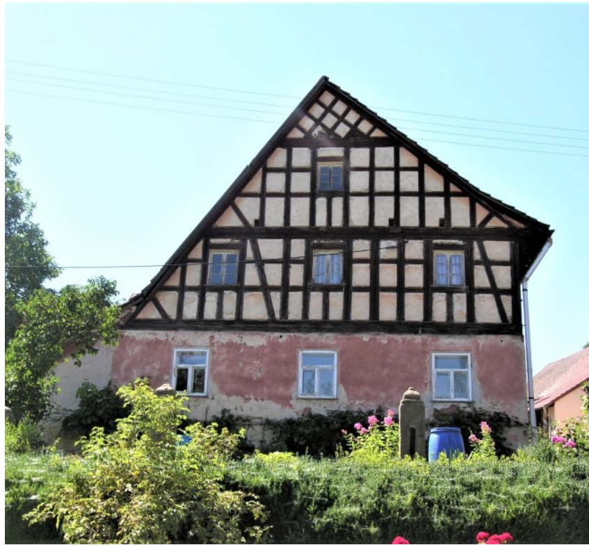
© (BLfD) Bildschöner Frackdachbau vor seiner Sanierung
