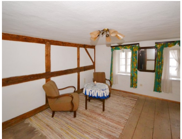
© (G. Gronauer) Zimmer mit Innenfachwerk im DG
