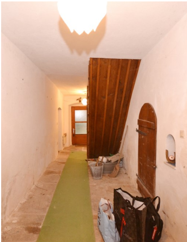
© (G. Gronauer) Flurbereich im Erdgeschoss
