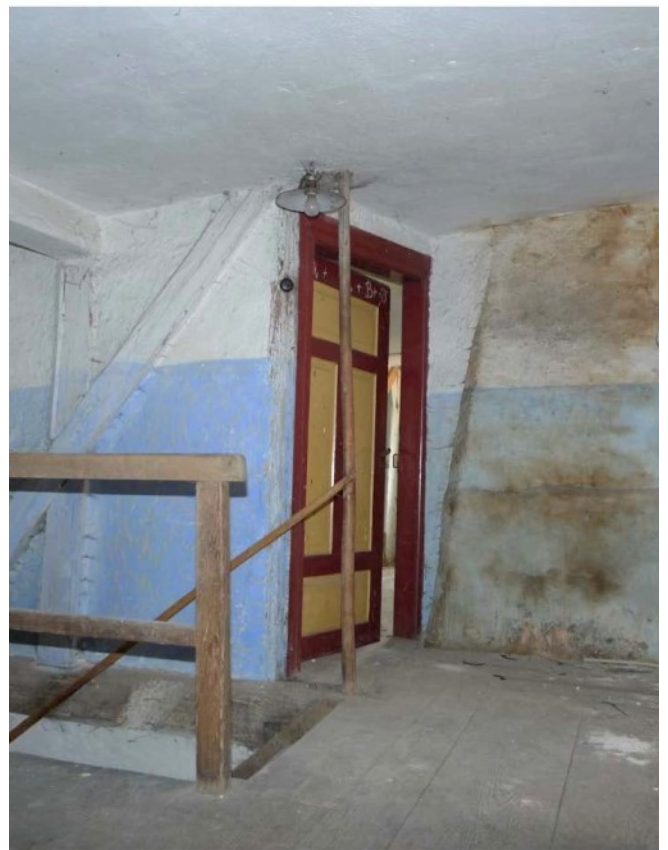
© (M. Beck) Treppenaufgang ins DG
