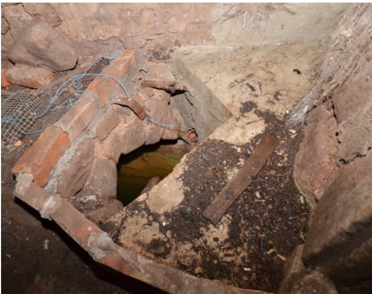
© (G. Gronauer) Grundwasserbrunnen
