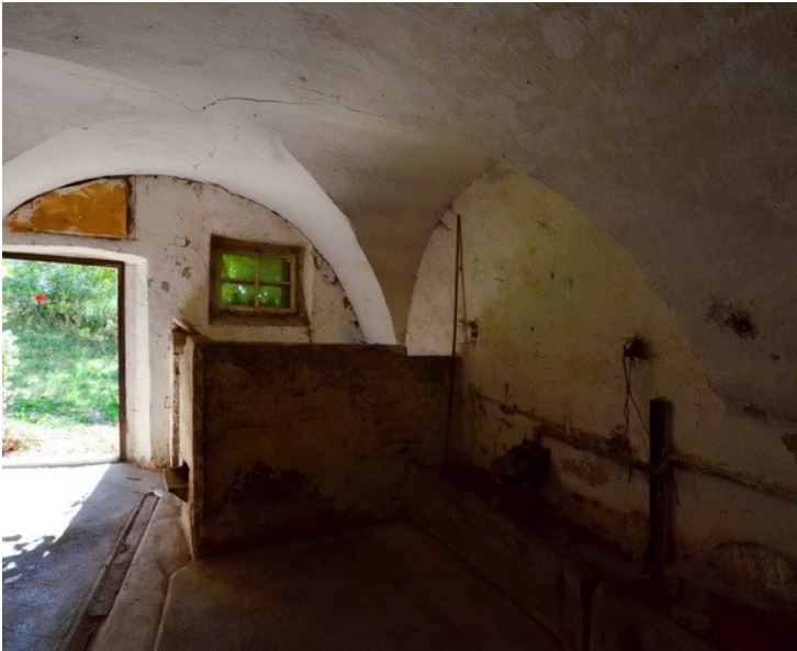
© (EdA) Kreuzgewölbedecke im ehem. Kuhstall
