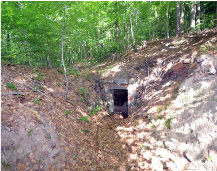
© (G. Gronauer) Eingang zum Felsenkeller
