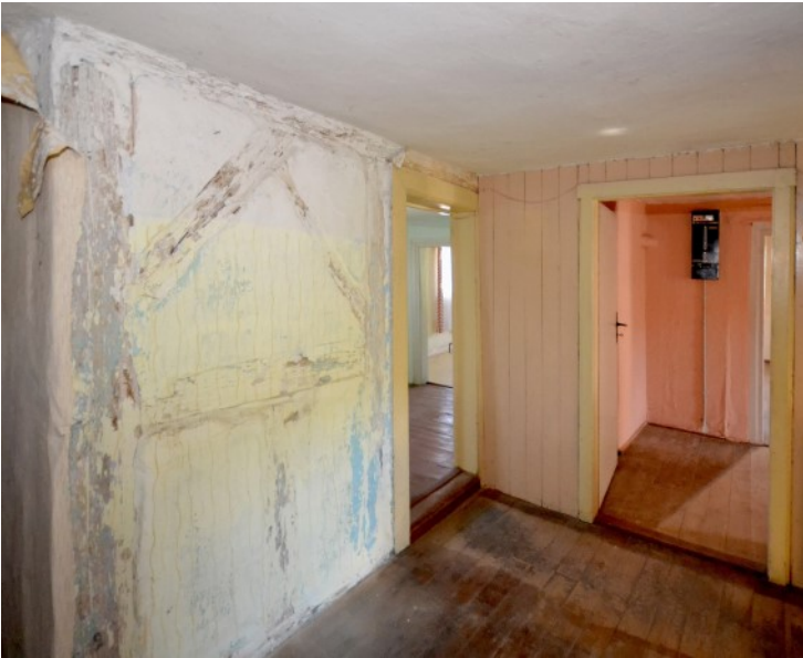
© (G. Gronauer) Flur mit Fachwerkständerwand
