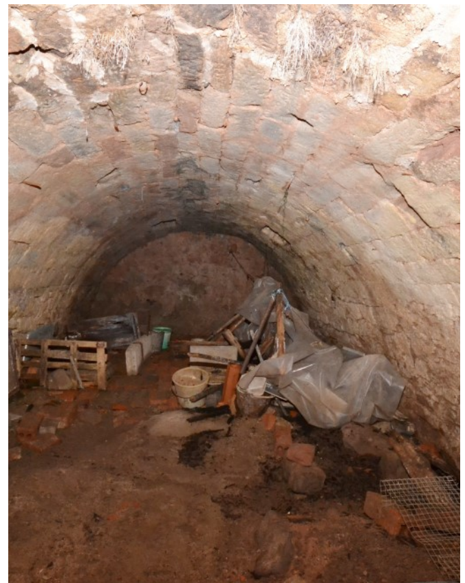
© (G. Gronauer) Keller mit Tonnengewölbe
