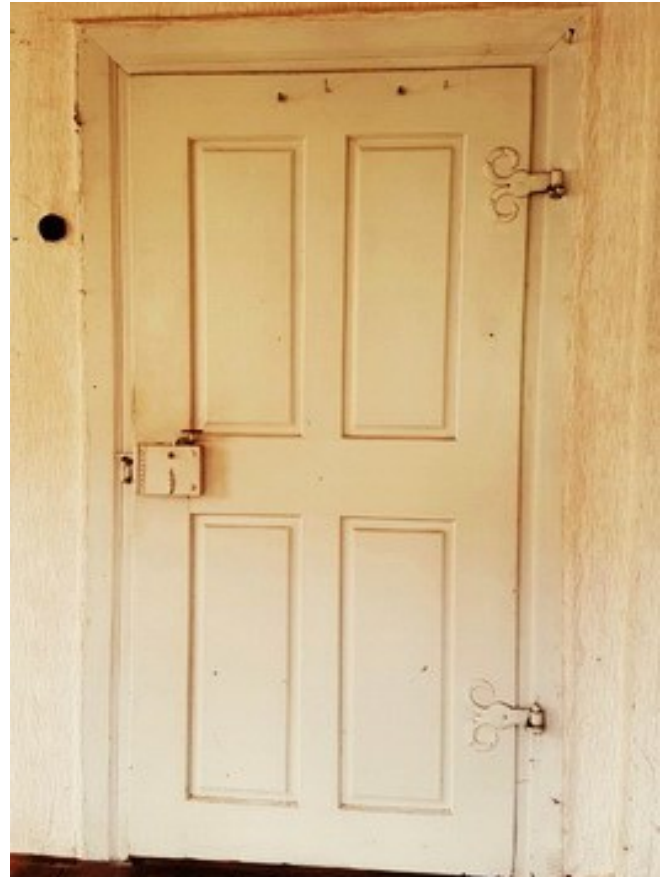
© (EdA) Historische Zimmertür
