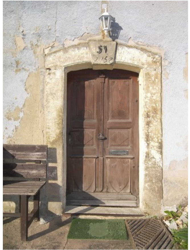
© (EdA) Hauseingang mit Sandsteinrahmung
