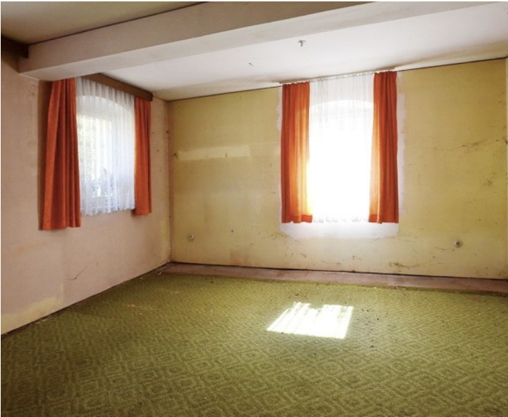
© (EdA) Holzbalkendecke unter Gipskarton
