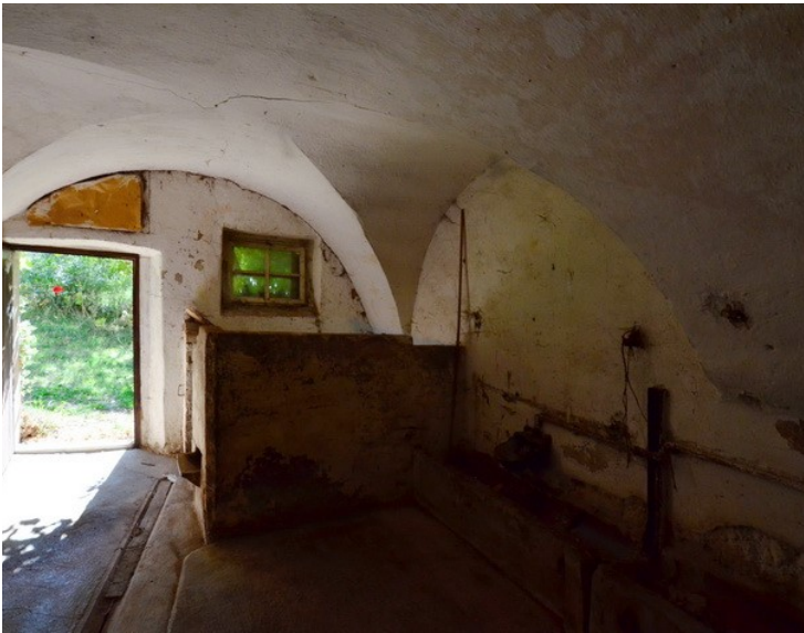
© (EdA) Gewölbedecke im ehem. Kuhstall
