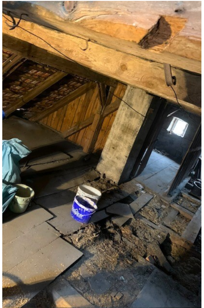
© (E. d. A.) Großzügiger Dachbereich
