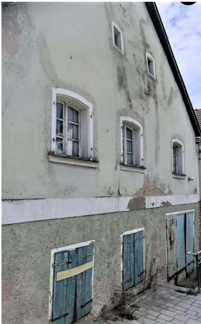
© (W. Reisinger) Giebelfassade mit Stichbogenfenstern
