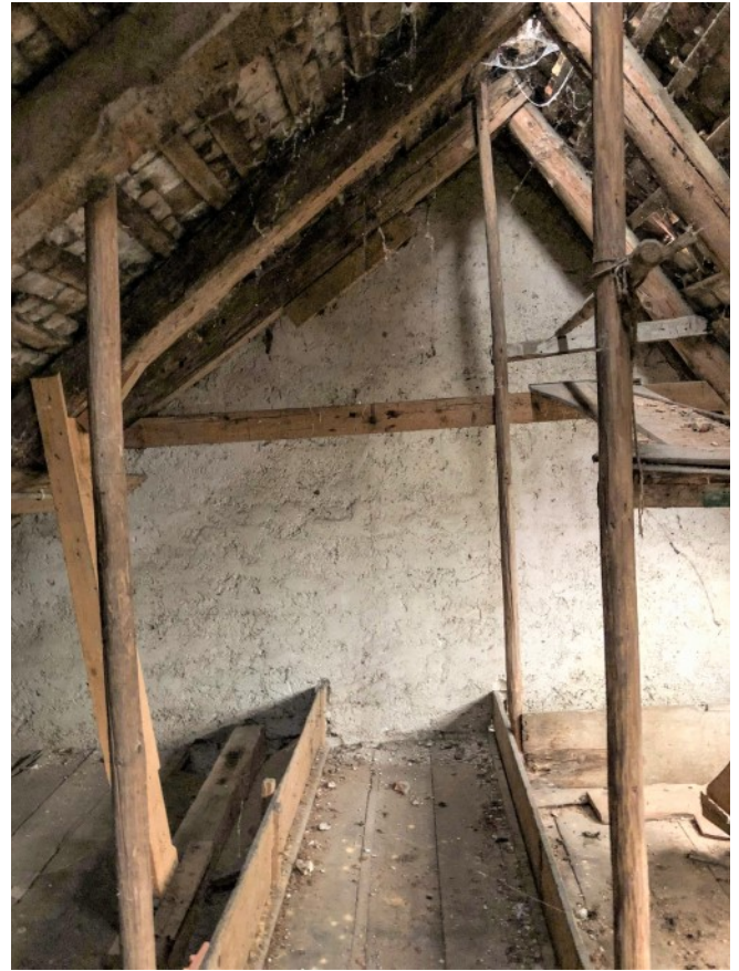
© (E.d.A.) Dachbereich der Scheune
