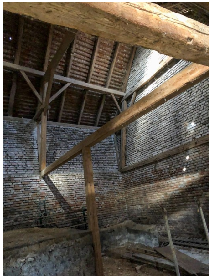
© (E.d.A.) Zu Wohnraum ausbaubare Scheune
