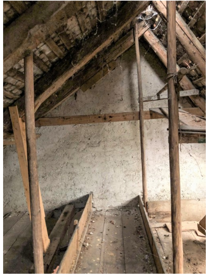
© (E.d.A.) Dachbereich der Scheune
