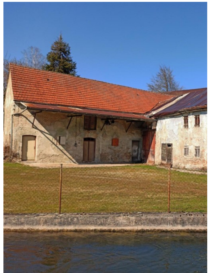
© (E.d.A.) Vielseitig nutzbare Scheune
