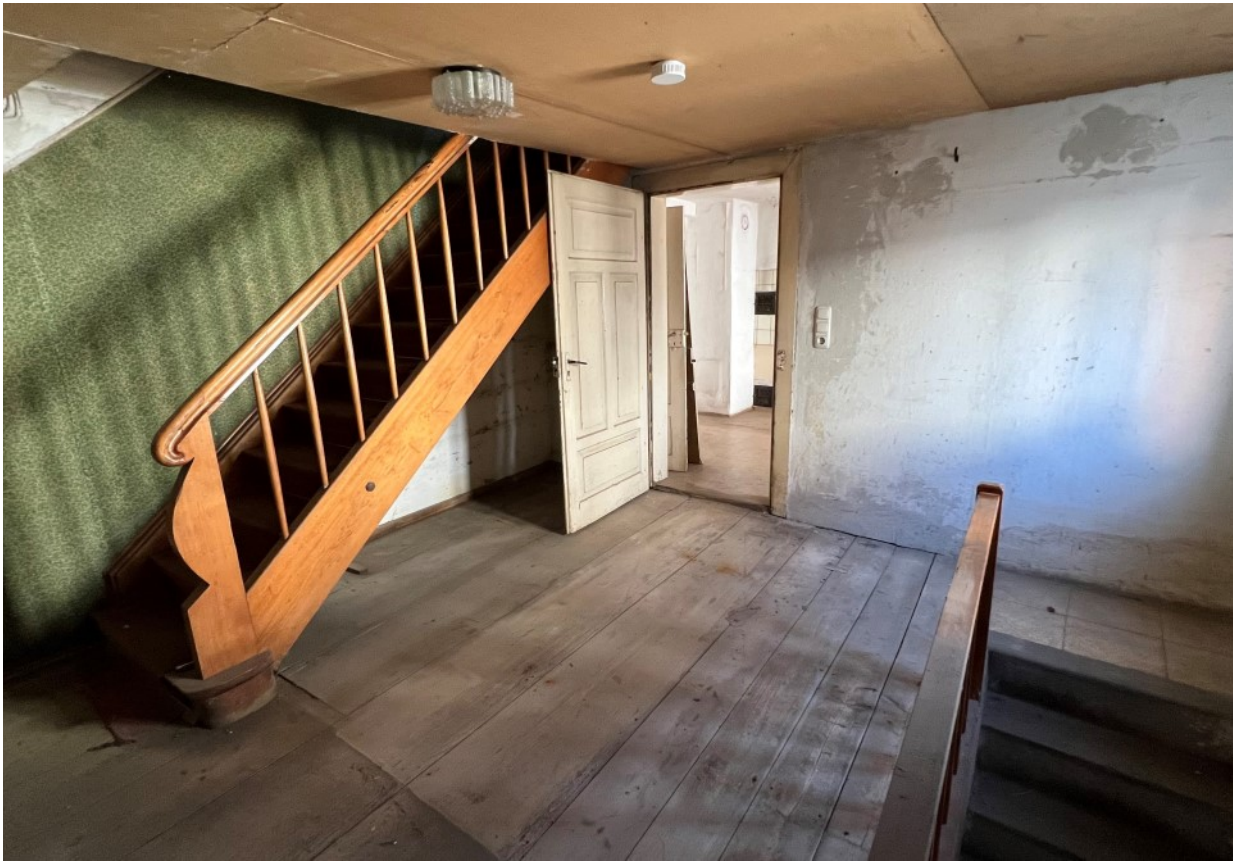
© (J. Schneider) Treppe ins OG
