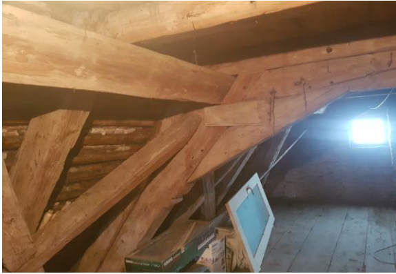
Detail von Dachstuhl
